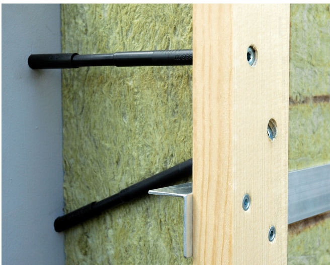
Abb. 2: System mit Distanzschrauben (Roger)
