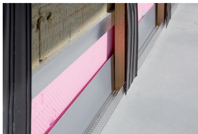
Abb. 1: Sockeldämmung
