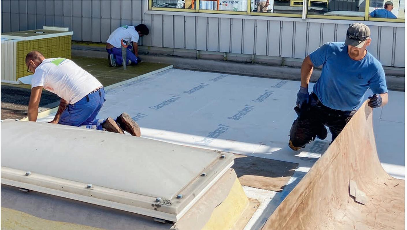
Rückbau Kunststoffdichtungsbahn Sika Sarnafil TG-66.
