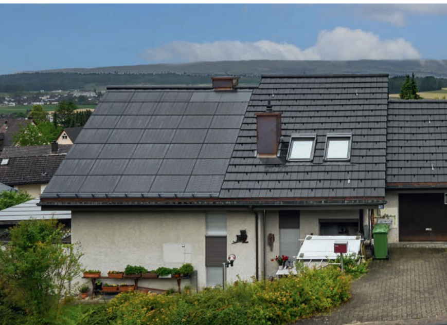
L'énergie solaire sur mesure: l'installation intégrée au toit convainc par son dimensionnement précis et son raccordement propre au toit.
