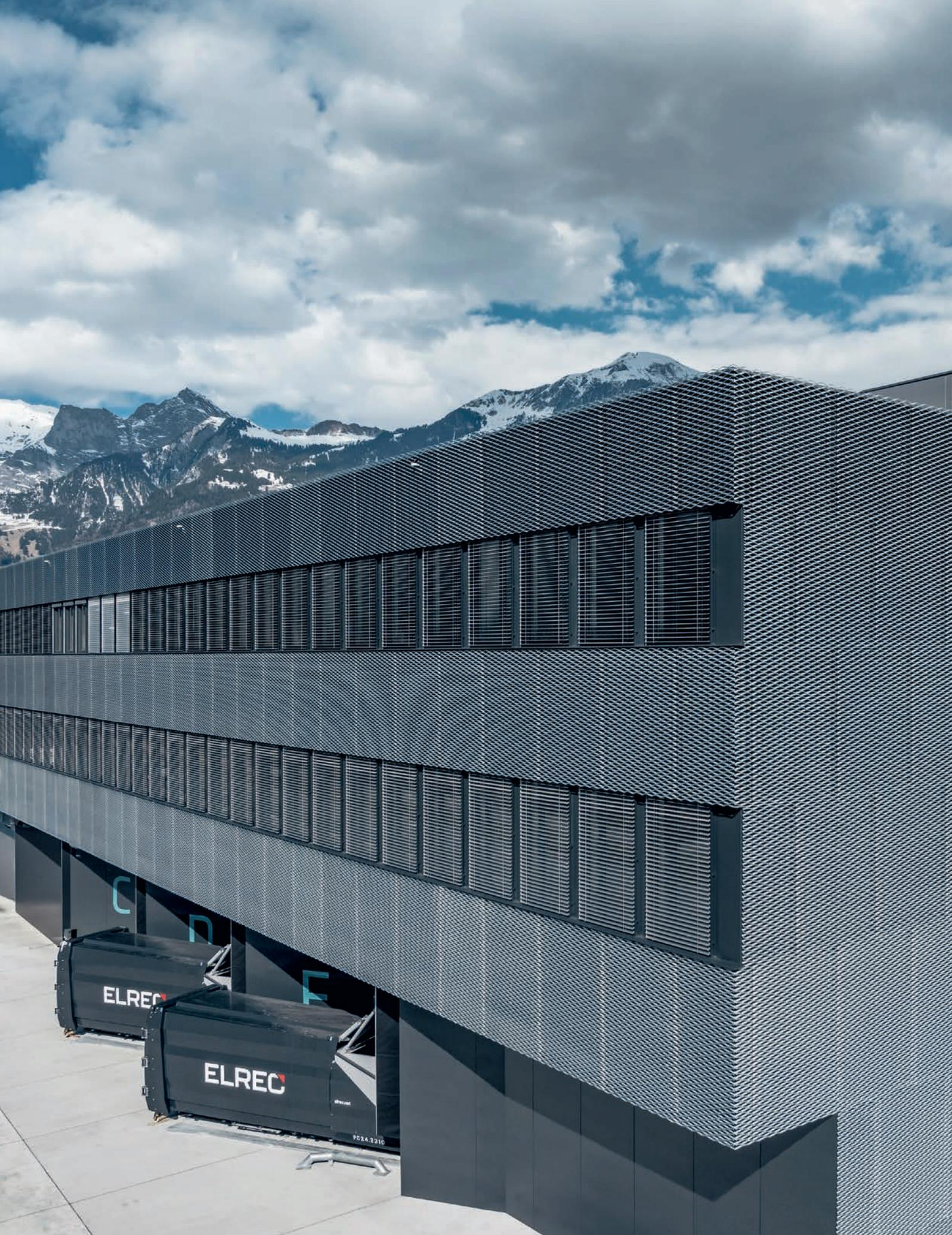
Beim jüngsten Erweiterungsbau in Zizers GR setzt INTEGRA Biosciences auf eine Streckmetallfassade mit Flumroc-Steinwolldämmung.
