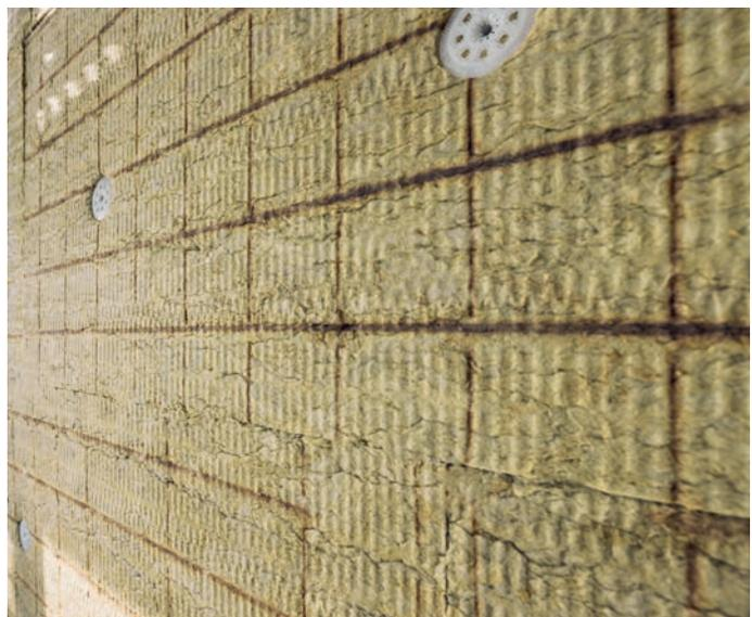
Auf einer Beton-Tragkonstruktion hat der Fassadenbauer Steinwolle-Dämmplatten DUO mit einer Dicke von 200 mm montiert.
