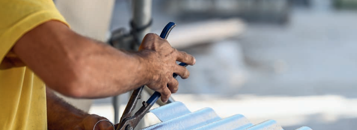
Beim händischen Zuschneiden der Alubleche ist exaktes Handwerk gefragt.
