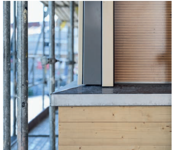
Die «Lucido»-Fassade produziert Solarstrom und sorgt in Güttingen auch für die Vorerwärmung der Frischluft.
