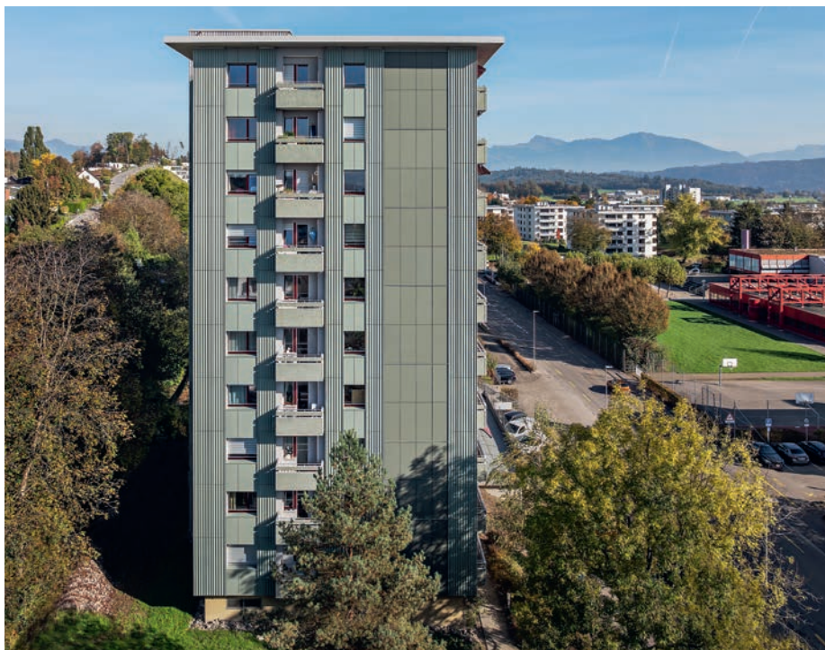
Ein zehngeschossiges Haus in Rapperswil-Jona am Zürichsee wurde vor Kurzem energetisch modernisiert. In die neue Fassade aus Faserzement wurde eine farbige und hocheffiziente Photovoltaik-Anlage integriert. Wie Ziernähte schmückt diese nun zwei Seiten des Hauses.
