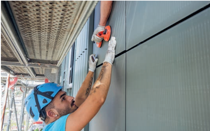
Die letzten Zentimeter eines Photovoltaik-Moduls auf seinem Weg zum passenden Ort. Im Hintergrund ist das Zusammenspiel mit der Ondapress und den Übergängen in Blech zu sehen.
