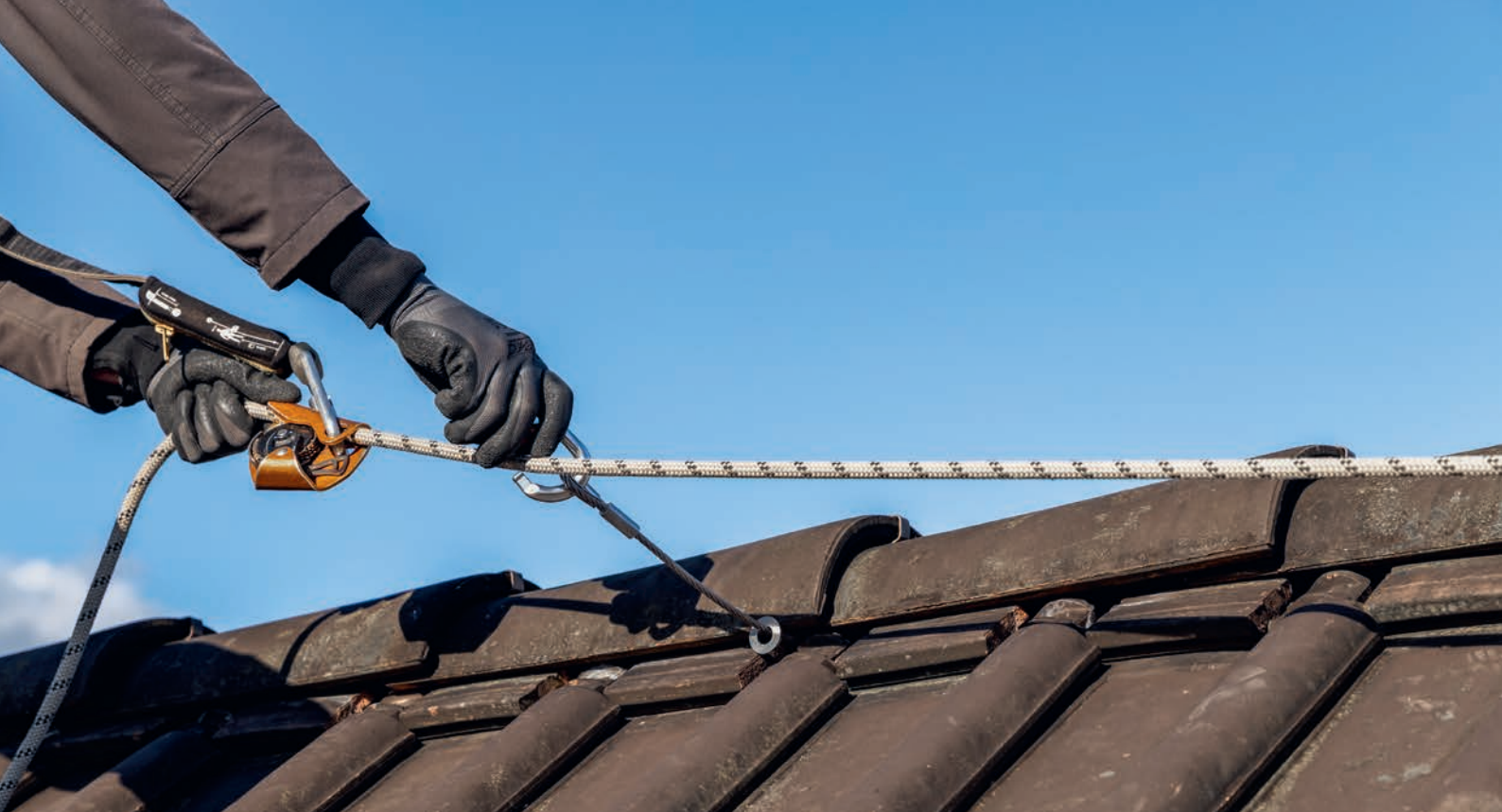
Antichute mobile avec corde à gaine centrale sur un dispositif d'ancrage permanent.
