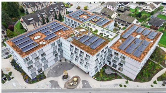
Figure 1 : Centre pour personnes âgées Hasilbrunnen, Langenthal, source : Hasilbrunnen AG, centre de compétences pour les personnes âgées
