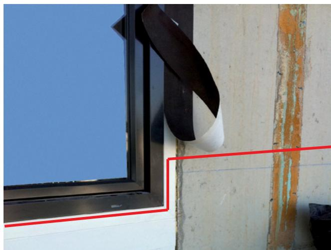
Fig. 20: Relever les bandes d'étanchéité contre le vent et la pluie battante dans la zone de raccordement du toit plat
