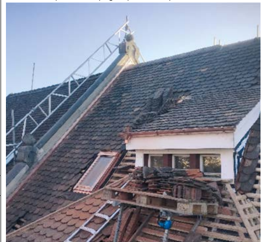
Photo : Séparation physique avec poutres en treillis
