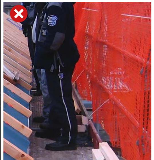
**Question 4.112 | Certains fabricants fournissent des éléments de garde-corps périphérique pour parois de protection de couvreur, non pas avec des treillis en acier ou en alu, mais avec des filets de sécurité selon SN EN 1263, comme ceux utilisés dans la construction de halles. De quoi faut-il tenir compte si j'utilise de tels filets ?**
