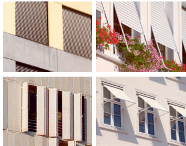
Externe, mobile et couvrant entièrement: stores à lamelles, volets roulants, volets et stores pare-soleil (de g. à d.) protègent efficacement de la chaleur.
