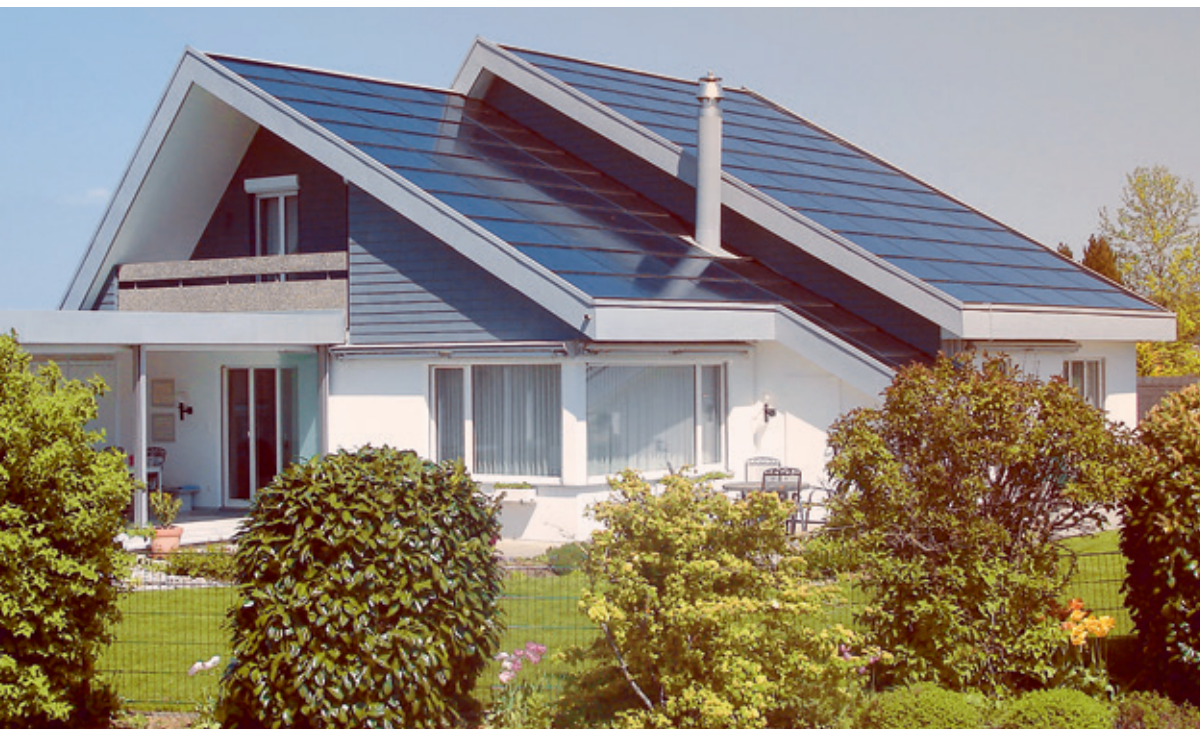
Lors de l'assainissement d'une maison familiale à Giebenach, le chauffage au mazout a été remplacé par une pompe à chaleur. L'installation photovoltaïque intégrée sur toute la surface du toit produit nouvellement une partie de l'électricité nécessaire. Source: SuisseEnergie
