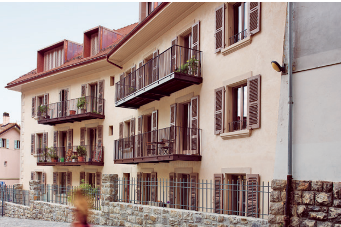
Dans ce bâtiment rénové à Lausanne, les balcons sont séparés du bâtiment d'un point de vue thermique et n'occasionnent donc pas de déperditions de chaleur. Photo: Thomas Hensingier
