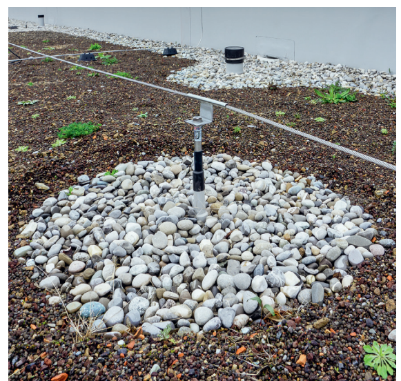
Auf dem Dach wurde ein Absturzsicherungs-Seilsystem inklusive Anschlagpunkten und Kurvenführungen montiert.
