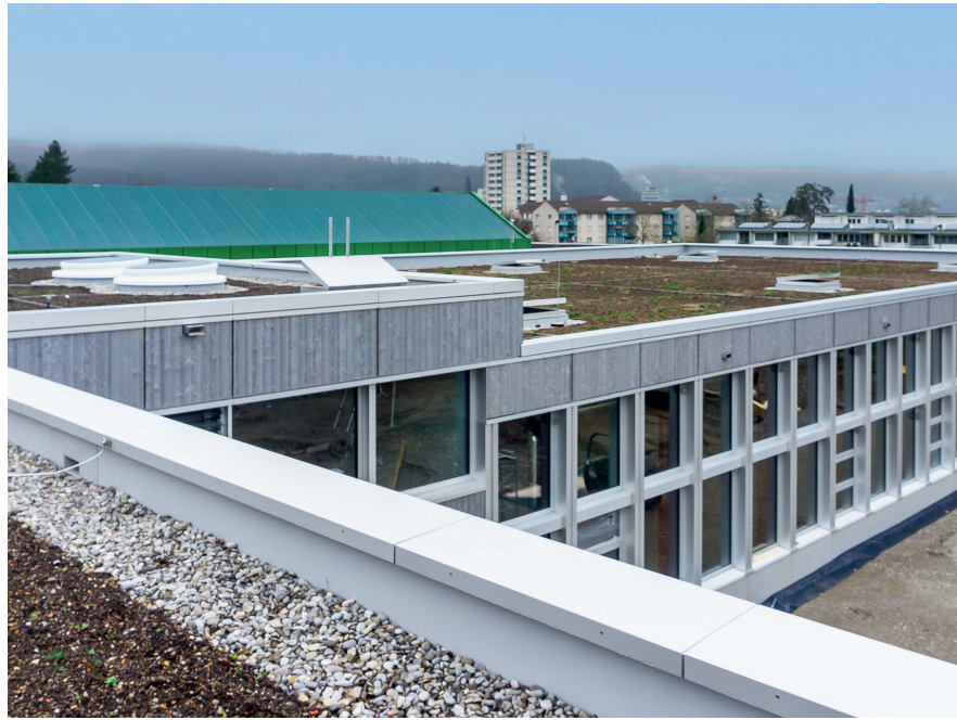
In Olten wird nach den Sommerferien die neue Schulanlage Kleinholz in Betrieb genommen.
