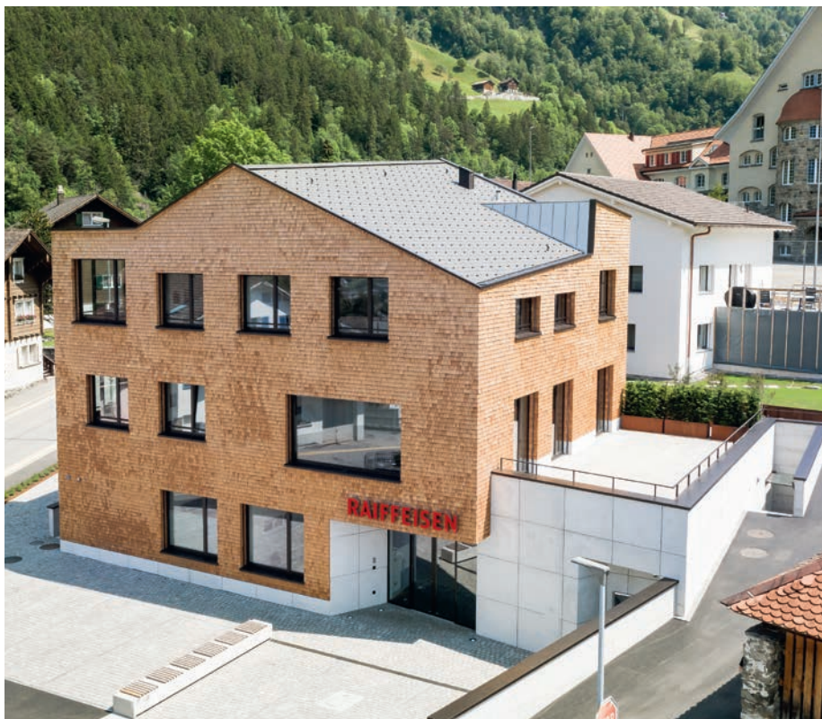
Raiffeisengebäude in Bürglen mit Minergie-Eco Label (UR-001-ECO).
