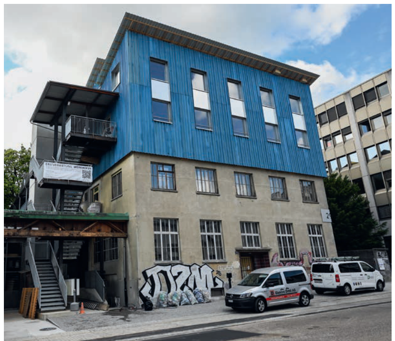
Das bestehende zweigeschossige Gebäude erhielt eine Aufstockung in Holzbauweise. Den äusseren Abschluss der Fassade bildet ein 1,25 Millimeter starkes, wiederverwendetes Alublech.
