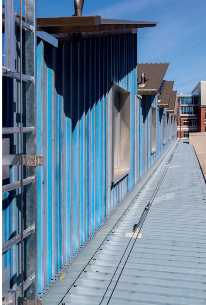
Blick auf das Dach des Laubengangs. Für dessen Begehung kann man sich am Seilsystem (rechts entlang der Kante sichtbar) sichern. Am linken Bildrand die zweite Leiter für den Zustieg zu den Sheddächern.
