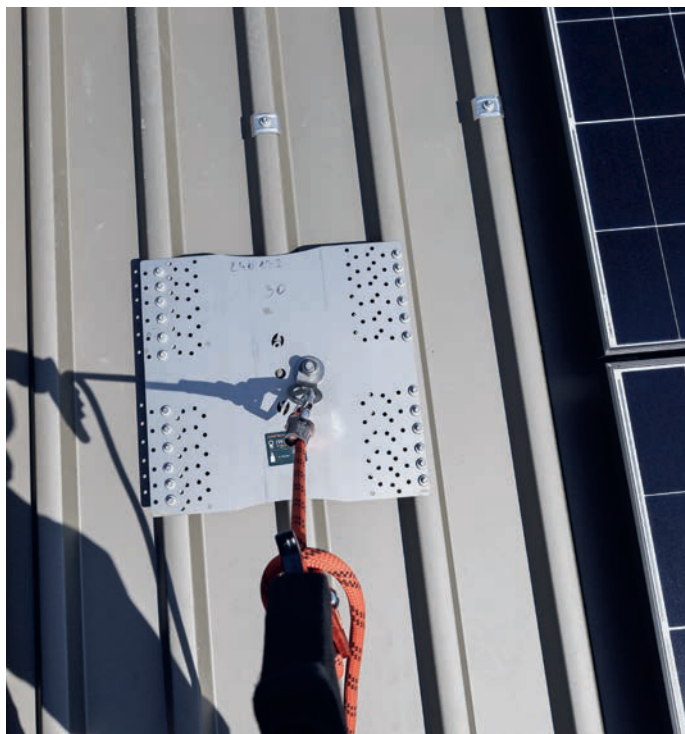
Jeweils 24 Selbstbohrschrauben verankern jeden Anschlagpunkt.
