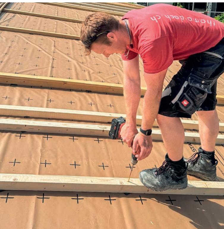
Marc Thoma beim Montieren von Konterlatten.
