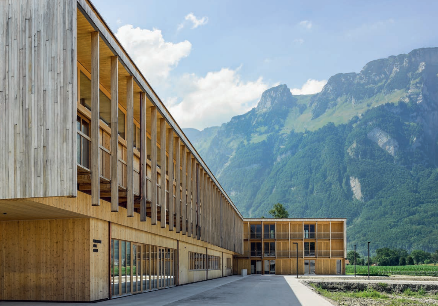
Landwirtschaftliches Zentrum St. Gallen in Salez: Die fixen Fassadenelemente sind für den sommerlichen Wärmeschutz entscheidend.
