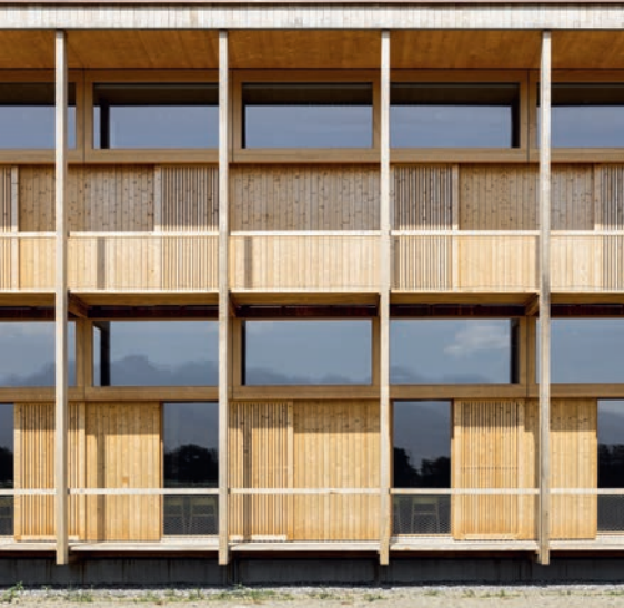
Südfassade: Der sommerliche Wärmeschutz definiert die Fensterfläche, beschattet wird mit Schiebeläden und fixen Fassadenelementen.
