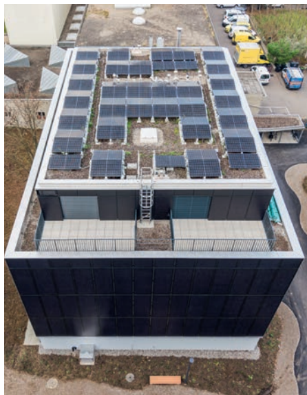
Flachdach: Sarnafil und extensiv begrünt, Photovoltaik-Anlage mit Zusammenschluss für Eigengebrauch (ZEV).
