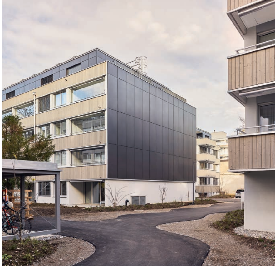
Fassade: Hybridbau mit Holzschalung und Kompaktfassade, Attikafassade mit Photovoltaik-Anlage, Holz-Metall-Fenster.
