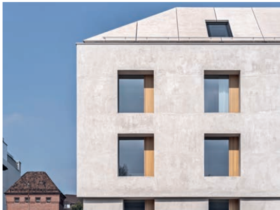
Die Struktur der Fassade ist einfach und klar.
