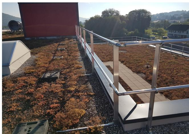
Fig. 23 Classe di equipaggiamento 3: Sistema di protezione laterale con zavorra
