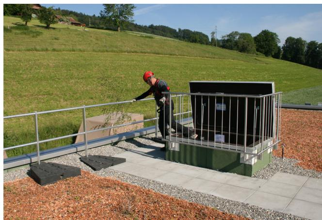
Fig. 36: Uscita dal tetto assicurata da una protezione laterale dalla zona pericolosa ad alto rischio di caduta. Se pianificata in modo ottimale, l'uscita dal tetto porterebbe alla zona di pericolo interna.
