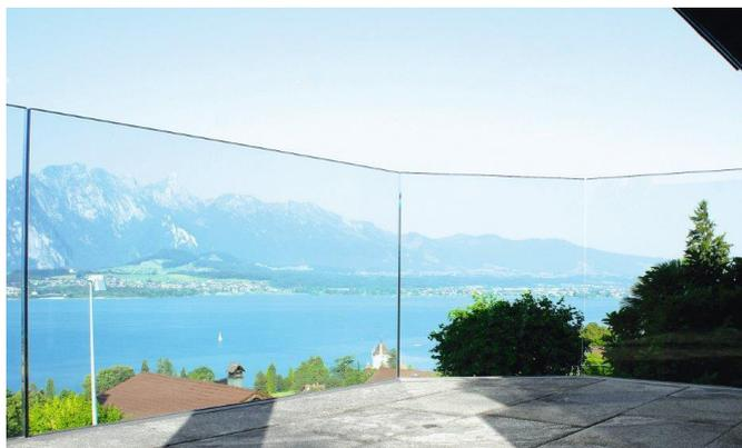
Fig. 26: Classe di equipaggiamento 4 per le aree del tetto accessibili al pubblico.
