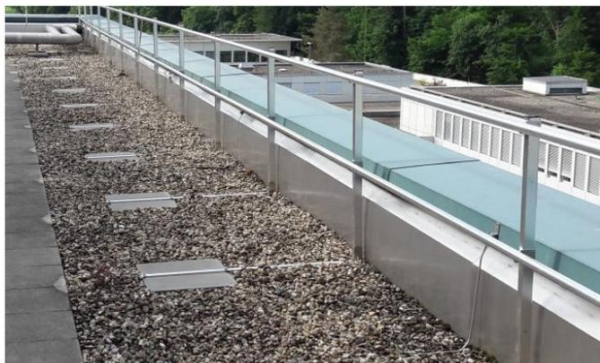
Fig. 24 Classe di equipaggiamento 3: sistema di protezione laterale con zavorra montata a filo pavimento
