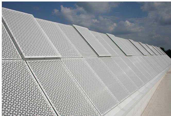
Fig. 38: Componenti a prova di sfondamento
