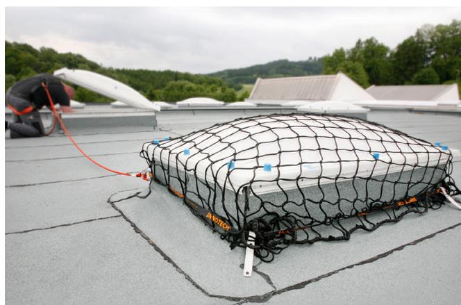
Abb. 39: Temporäre Lichtkuppelsicherung
