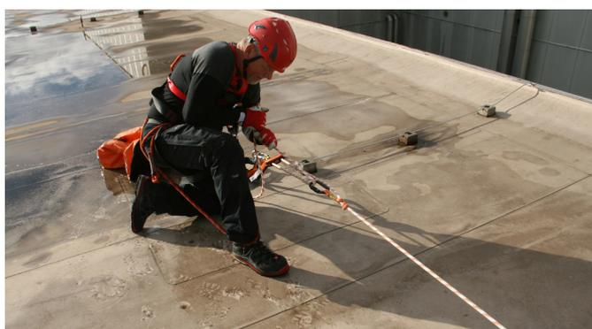
Fig. 10: Sistema di funi temporanee (Life-Line) fissato al EAP con moschettoni
