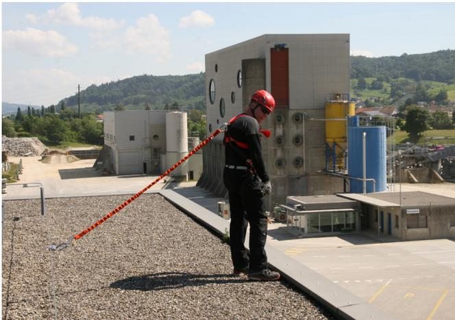
Fig. 1: Sistema di ritenuta con cordino di lunghezza fissa al dispositivo di ancoraggio
