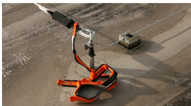
Fig. 12: Assorbitore di energia installato nel sistema di cavi temporanei (Life-Line) per limitare le forze sui punti di ancoraggio
