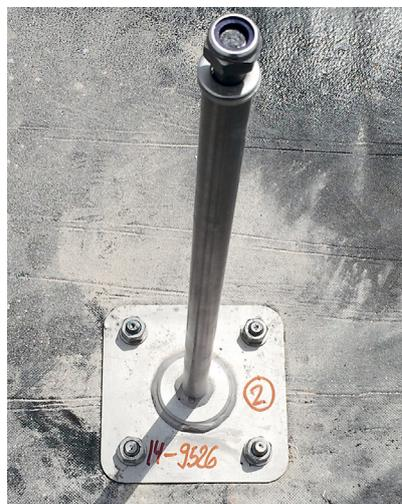
Fig. 41: Supporto completamente assemblato e numerato per la documentazione di installazione (numero dell'oggetto e numero del supporto)
