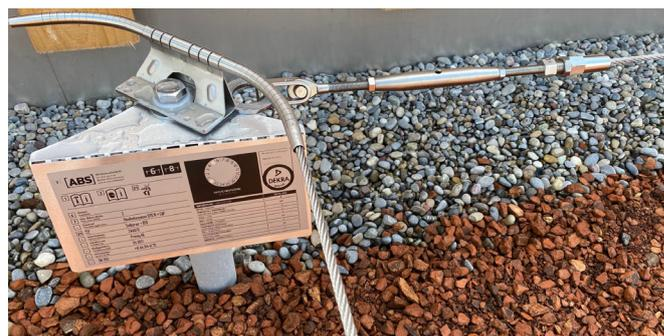
Fig. 43: Etichettatura specifica dell'oggetto di un sistema di cavi
