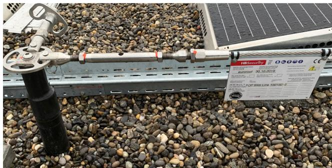
Fig. 42: Etichettatura specifica dell'oggetto di un sistema di cavi
