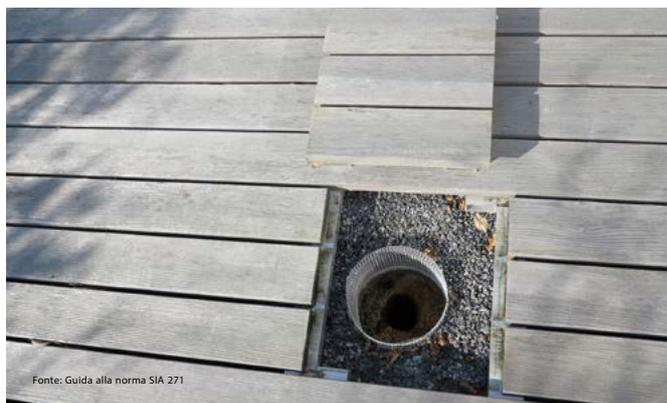
Fig. 43: Nelle griglie in legno si può fare a meno di una griglia per la bocchetta di scarico dell'acqua piovana. Dovrà tuttavia essere presente un'apertura di servizio nell'area della bocchetta di scarico dell'acqua piovana.
