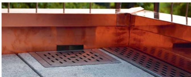
Fig. 32: Troppopieno con griglia forata e canaletto di drenaggio (dalla guida alla norma SIA 271).
