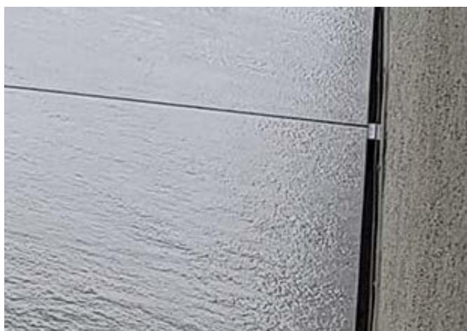
Fig. 35: Giunto di raccordo  $\geq 10$  mm con distanziatore.
