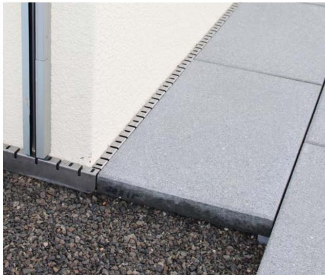
Fig. 33: Raccordo perimetrale con profilo di giunzione.
