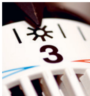
Les vannes thermostatiques régulent le débit de l'eau chaude de chauffage à travers le corps de chauffe et adaptent la puissance de l'installation de chauffage en fonction des besoins.
