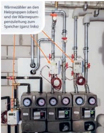
Wärmezähler an den Heizgruppen (oben) und der Wärmepumpenzuleitung zum Speicher (ganz links)
