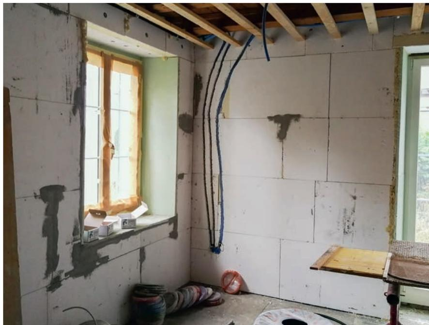
Etappe 2: Modernisierung Einliegerwohnung. Empfehlung: Für das Einlegen der Rohre und Elektroinstalltionen sind diese auf der warmen Seite der Wärmedämmung einzufräsen und die Rohre einzukleben. So wird vermieden, dass die Rohre auf der kalten Seite sind und Kondensat verursachen können.
