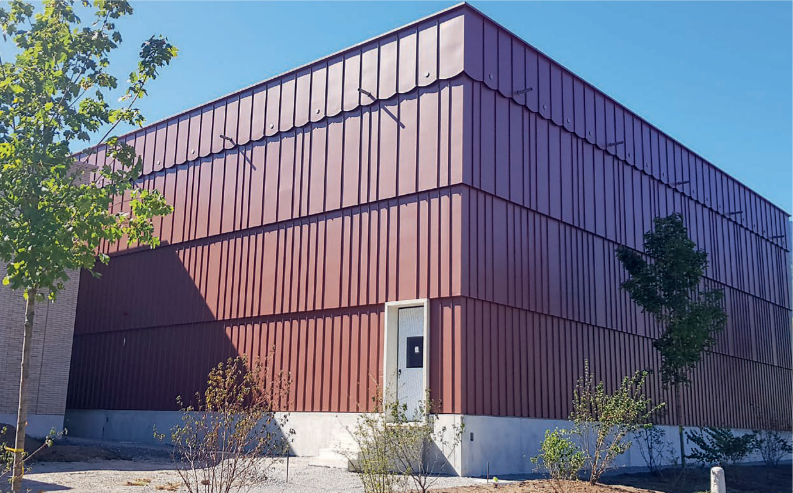
Süd-Ost-Fassade vom fertiggestellten Produktionsgebäude.
