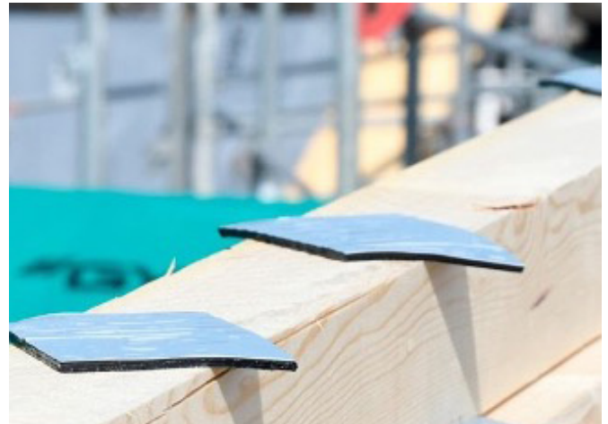
Abb. 12: Befestigungsmitteldichtungen werden rautenförmig unter der Konterlattung angeordnet um den Wasserfluss zu optimieren.
