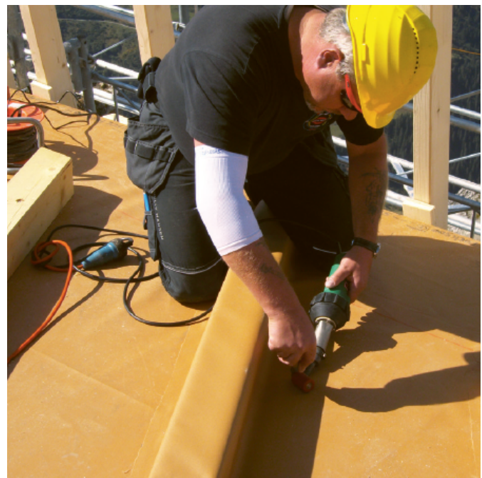
Abb. 3: Komplettes Einschweissen der Konterlatte.
