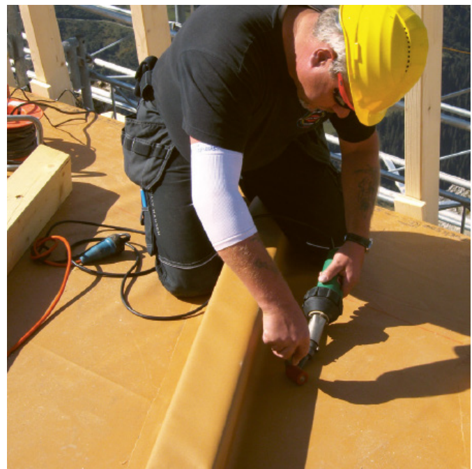
Abb. 3: Komplettes Einschweissen der Konterlatte.
