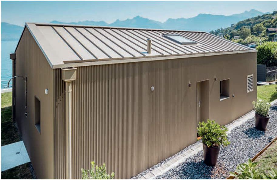
PREFA-Komplettsystem: vom PREFALZ am Dach, über Dachentwässerung bis zur Zackenprofil-Fassade.
