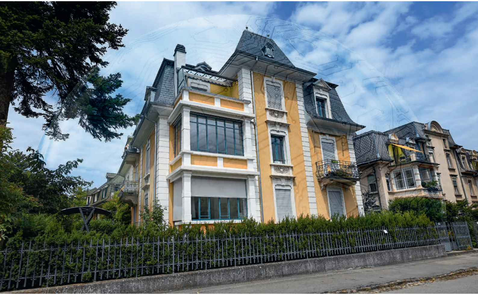
Wohnhaus im Breitenrainquartier (Bern). Das Dach ist vollständig mit Naturschiefer gedeckt, speziell ist der französische Grat, für den die Steinplatten von Hand und auf Gehrung (45-Grad-Winkel) zurechtgesägt wurden. Das Lieblingsobjekt von Chrigu Jost.
