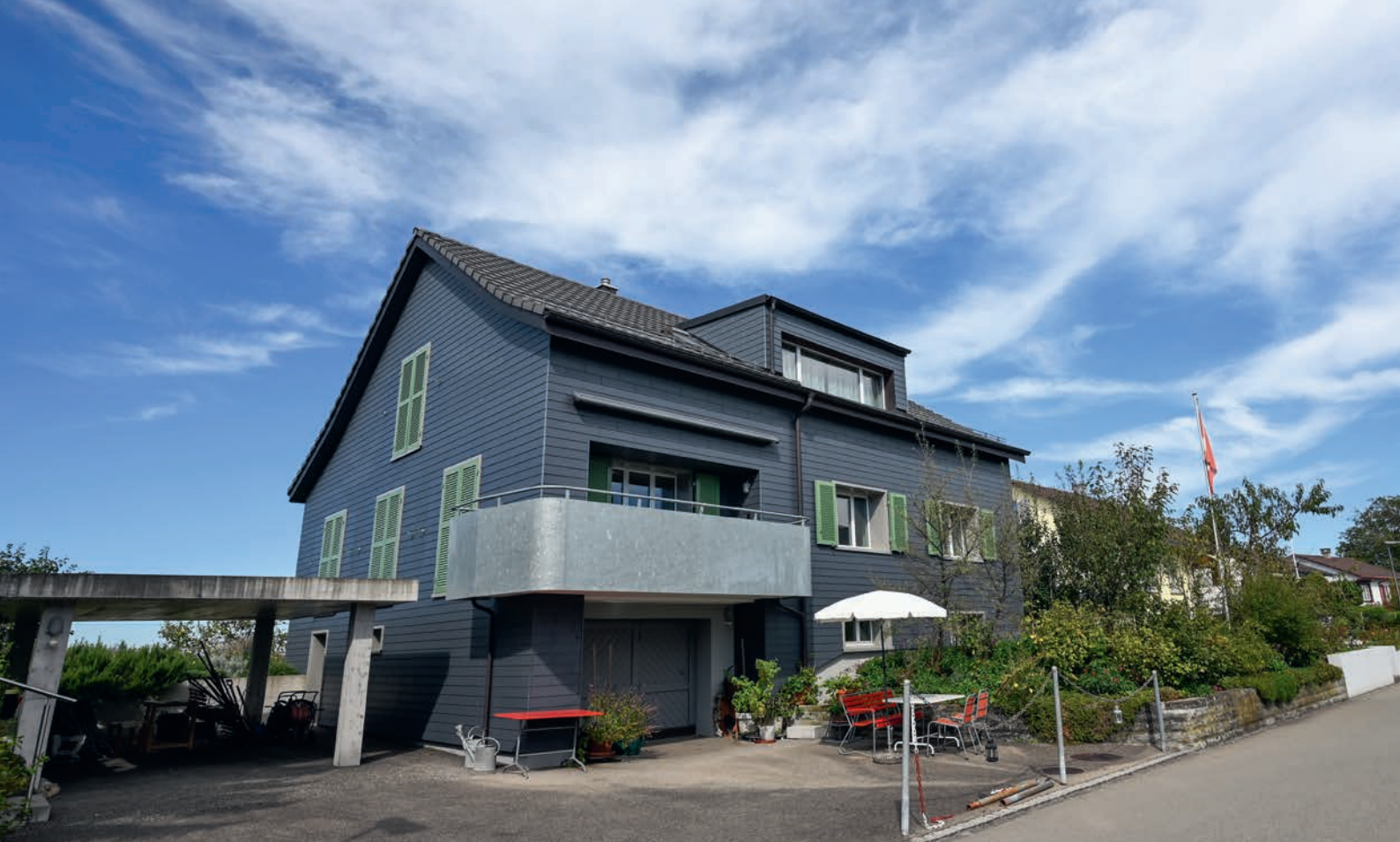
Ein altes Haus im neuen Kleid: Bei diesem Einfamilienhaus in Wittenbach SG wurde die gesamte Gebäudehülle umfassend modernisiert.
