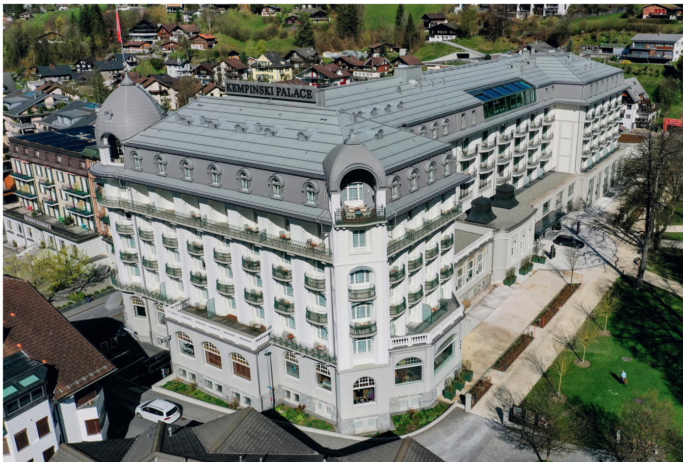
Das Mansardendach vereint das historische Hotel mit der Erweiterung.
