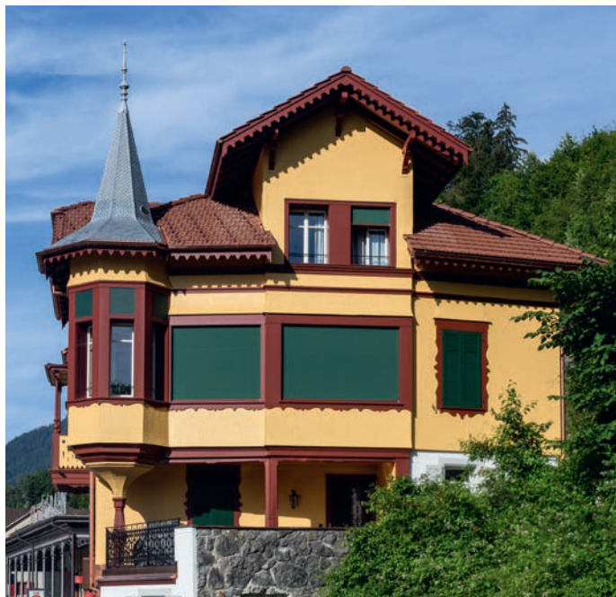
Nordseitig ist das Giebeldach des historischen Direktorenhauses als Walmdach ausgebildet und wird auf zwei Seiten von Giebellukarnen durchbrochen.
