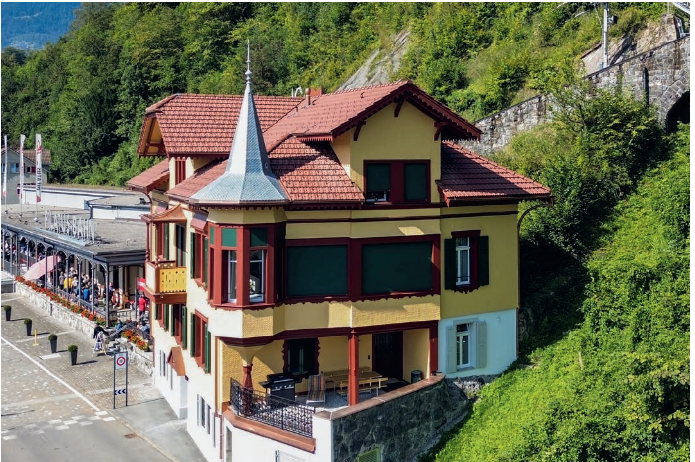
Die Bauherrschaft legte Wert auf die Bewahrung der historischen Zeitzeugen und renovierte das denkmalgeschützte Direktorenhaus in Alpnachstad.
