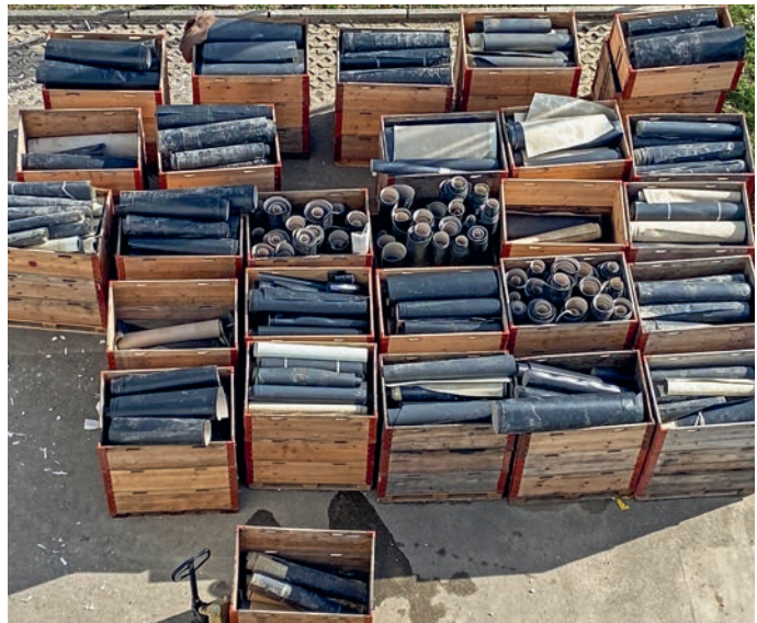
Materialien aus dem Rückbau von Dachbahnen werden sortenrein gesammelt, in Transportbehältern bereitgestellt und durch Sika abgeholt.
