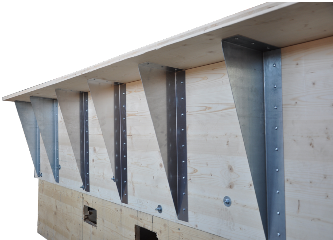
Abb. 7: Beispiel des Dachrandtyps 4.6, Aufnahme vom Praxistest
