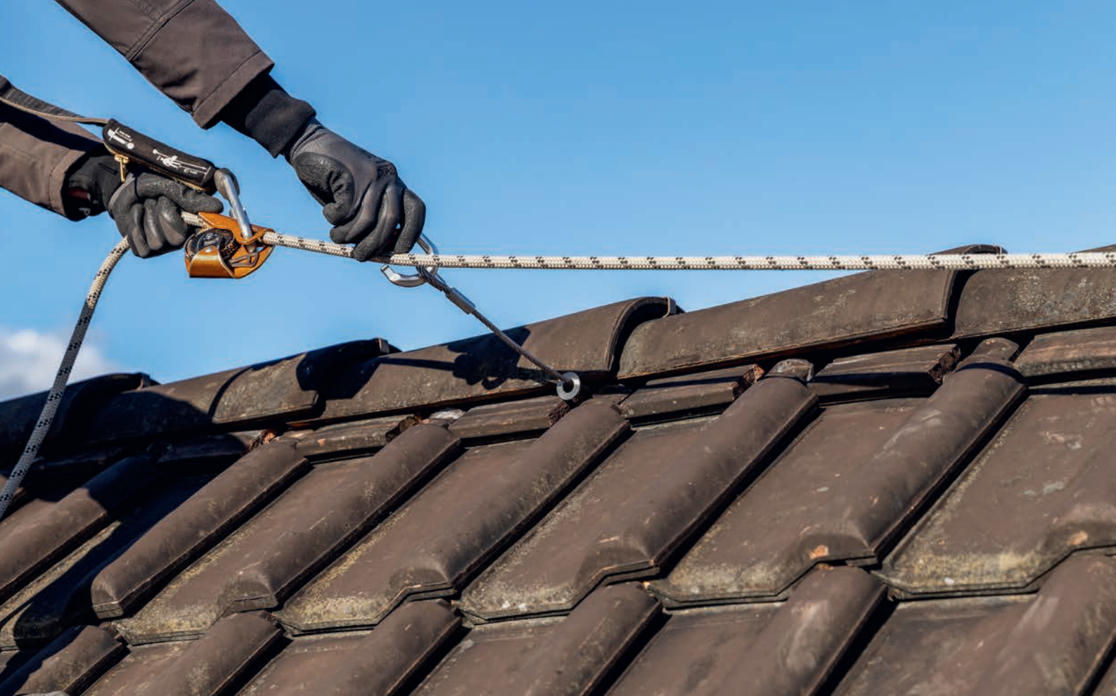
Mitlaufendes Auffanggerät mit Kernmantelseil an einer permanenten Anschlagereinrichtung.
