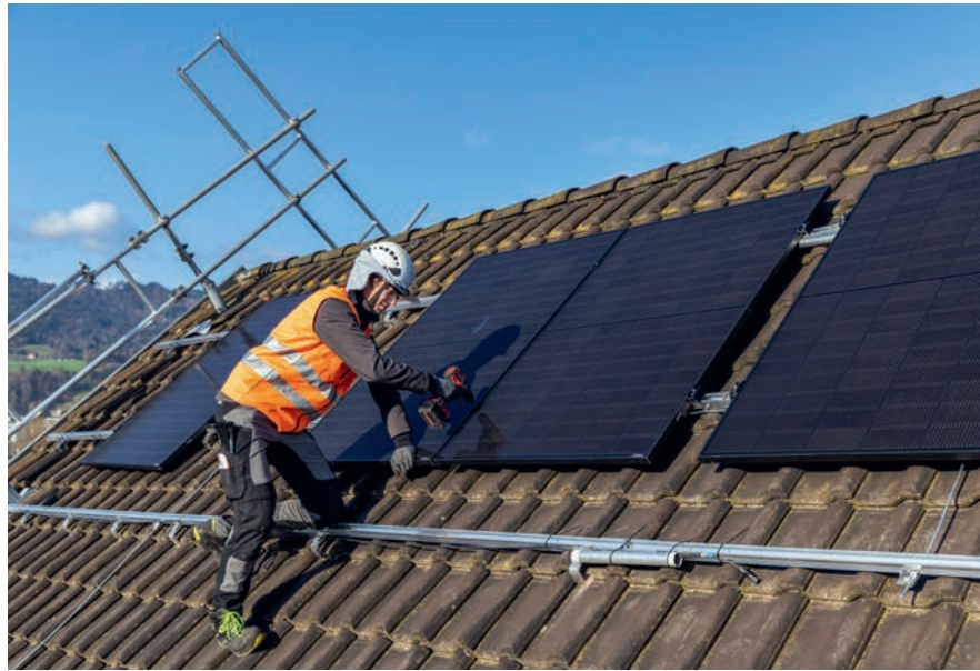
Seitenschutz als giebelseitige Kollektivschutzmassnahme gegen Absturz.
