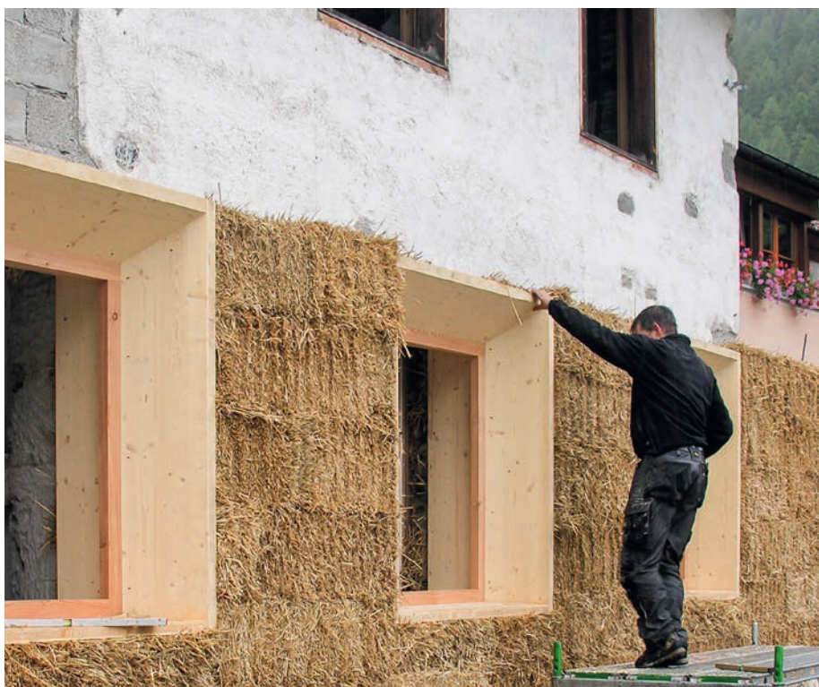
Baustoffe aus nachwachsenden Rohstoffen verursachen deutlich weniger Treibhausgasemissionen. Dieses Foto zeigt das Projekt «Casa Steila Mar» oder Haus «P&W» in Susch, bei dem die Aussenfassade mit Stroh thermisch saniert wurde. Foto: Atelier Schmidt
