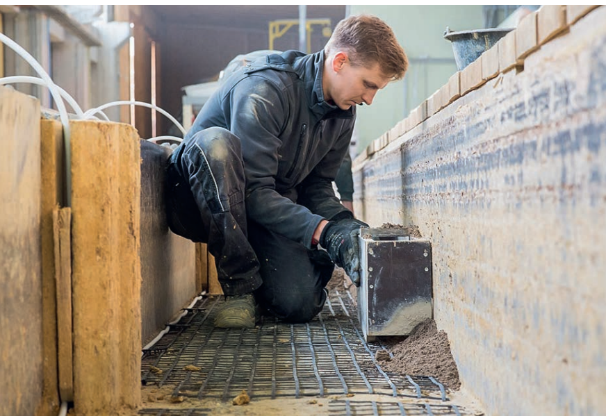
Bauelemente aus Lehm werden in der Werkhalle vorproduziert und später für die Konstruktion einer Fassade verwendet. Foto: Emmanuel Dorsaz
