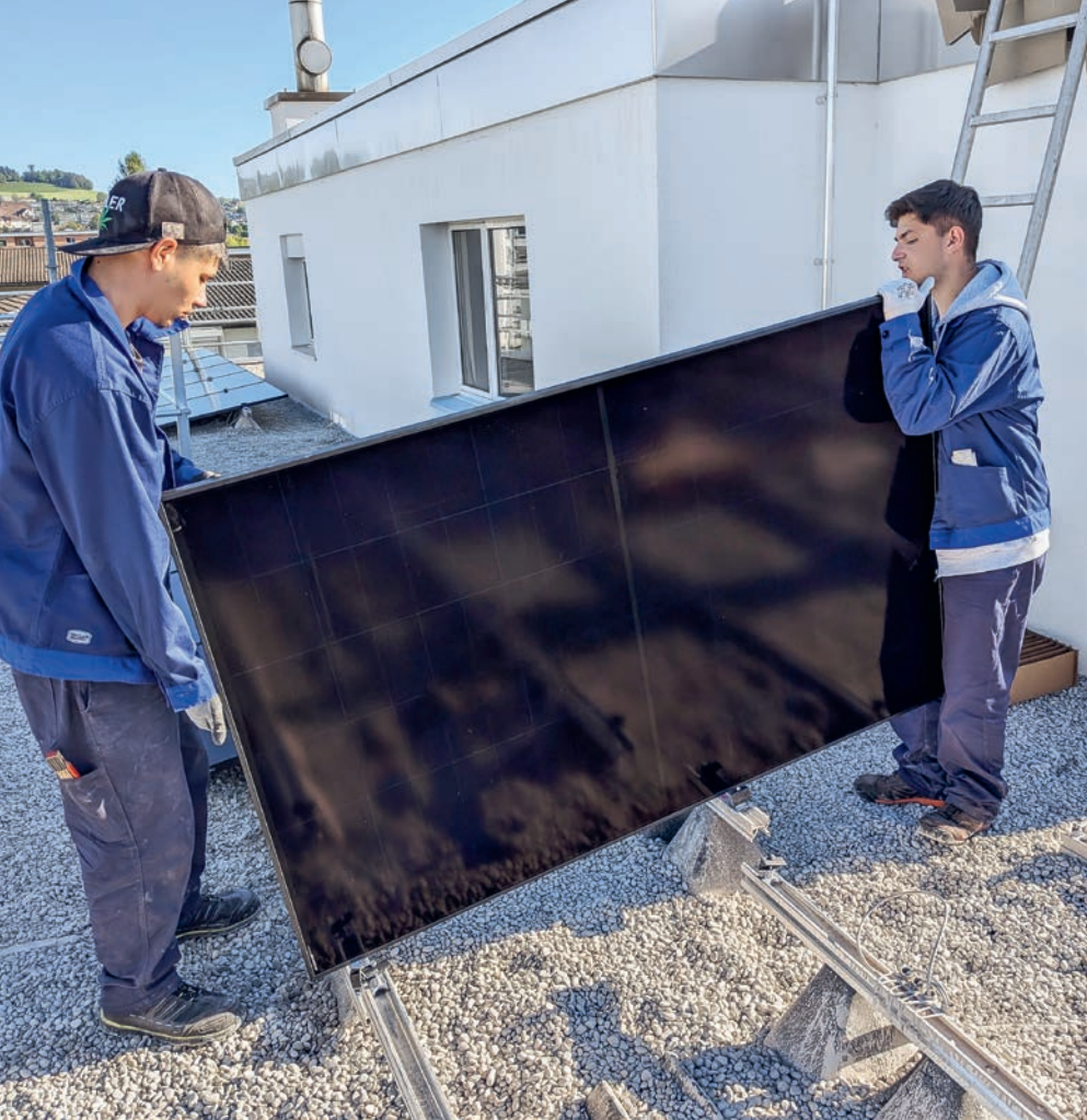
Die Lernenden beim Verlegen einer Photovoltaik-Anlage auf einem Flachdach in Zuzwil.
