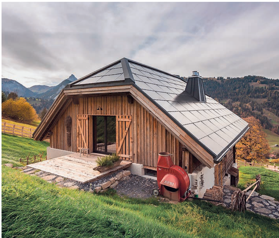
Photovoltaik-Anlagen sind wartungsarm – aber nicht wartungsfrei. Foto: 3S Swiss Solar Solutions AG.
