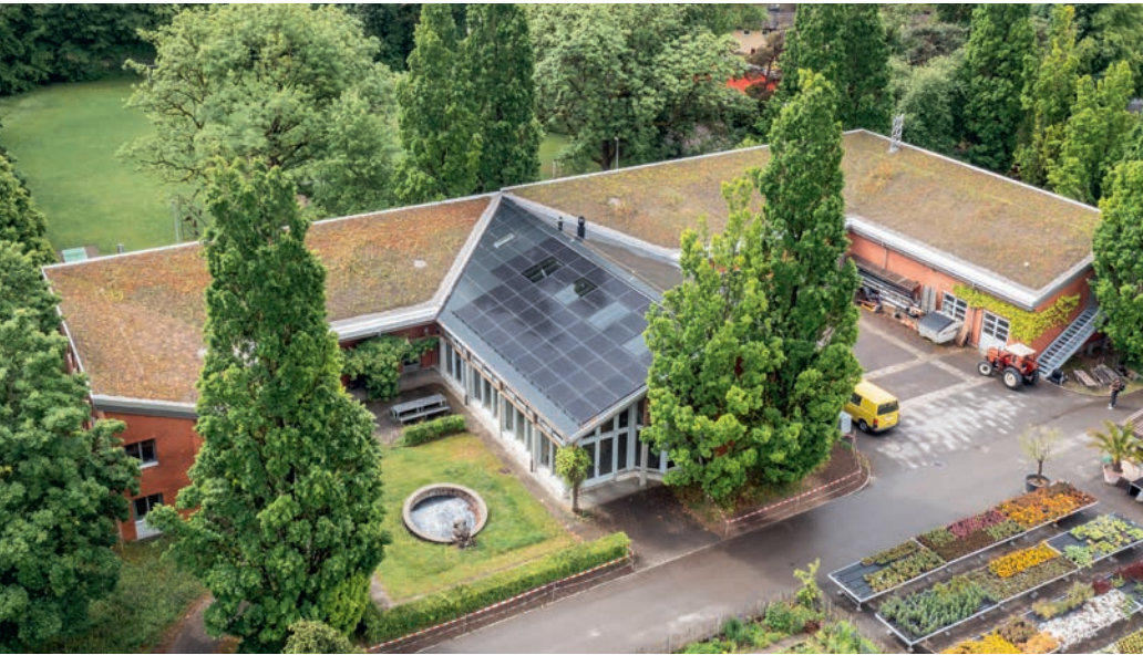
Die Dachflächenfenster integrieren sich harmonisch in die Photovoltaik-Anlage.
