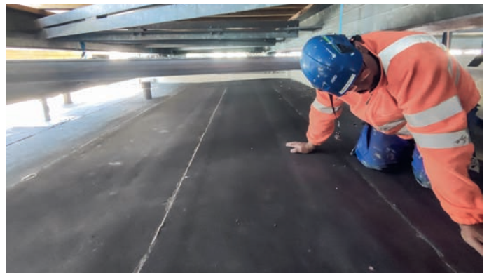
Ungewohnte Bedingungen auf dem Dach: Hindernisse und enge Platzverhältnisse beim Einbau des Dachsystems.
