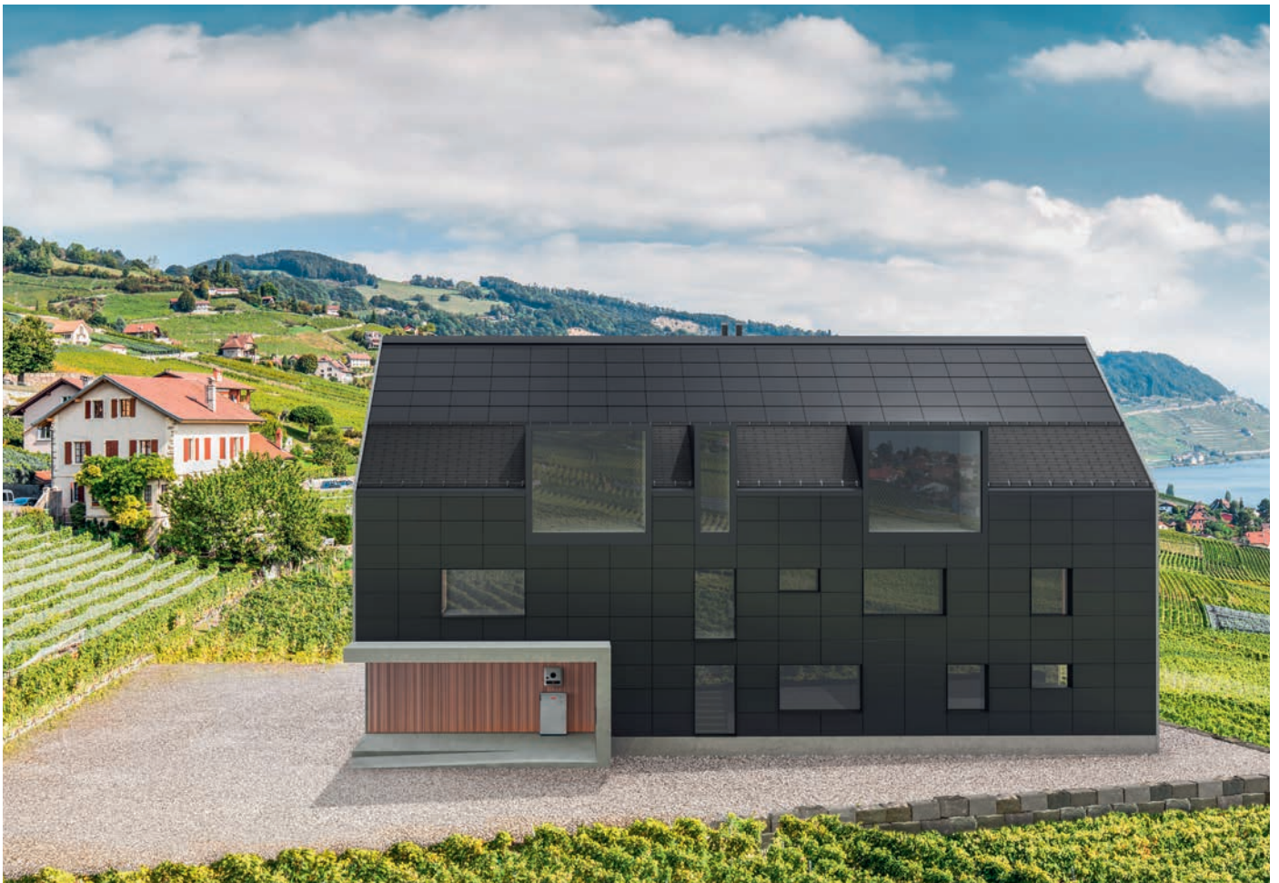
Speicherbatterien sind heute wesentlich kompakter, effizienter und preislich attraktiv. Gebäudeinterne Speicherlösungen sind daher eine echte Option.
