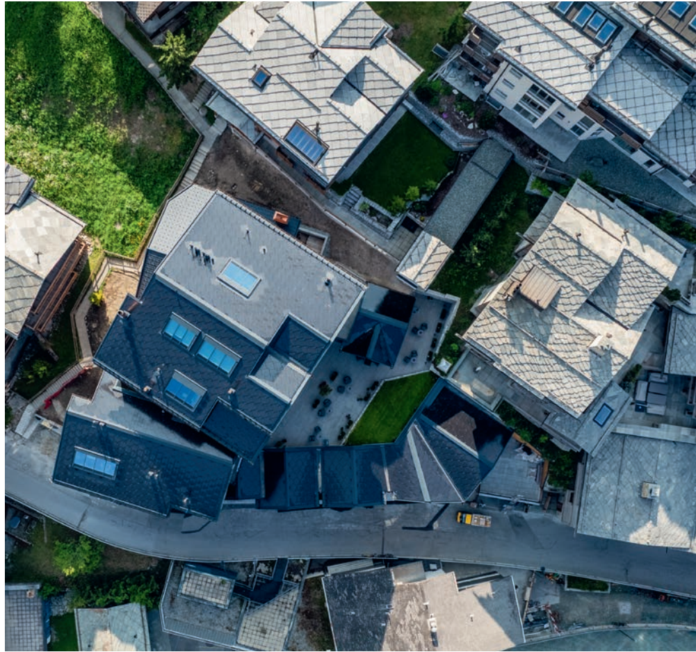
1116 integrierte Solarziegel liefern 82,4 Kilowattpeak saubere Energie für das Vier-Sterne-Haus.
