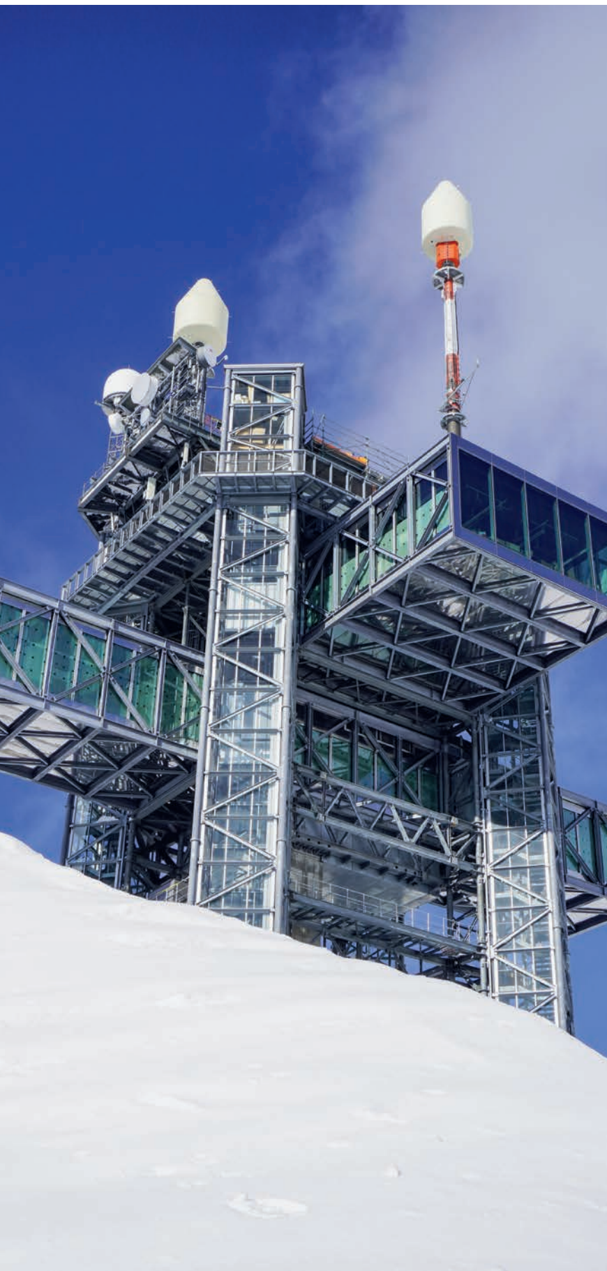
Der neue Titlis Tower mit zwei eingeschobenen Baukörpern und vier Erschliessungstürmen.
