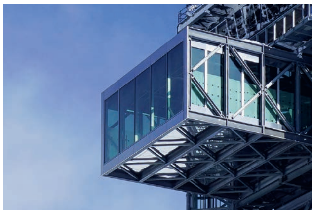
Der eingeschobene Baukörper beherbergt das Joseph's Restaurant.
