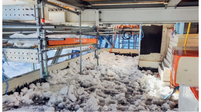
Hochgebirgsbedingungen herrschen bei den Dacharbeiten. Fotos: Beat Keiser, Abdichtungsbau Durrer AG
