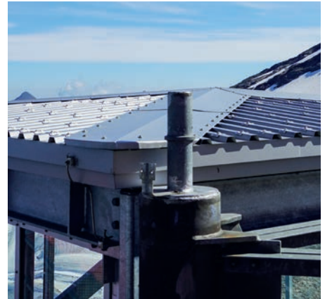
Zum Schutz der Dachhaut vor Eisschlag wurde zwischen Abdichtung und Abdeckung ein eingepasster Metallrost verlegt. Foto links: Beat Keiser, Abdichtungsbau Durrer AG
