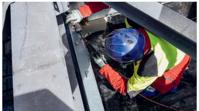
Engste Platzverhältnisse beim Schweißen. Foto: Paul Bauder AG
