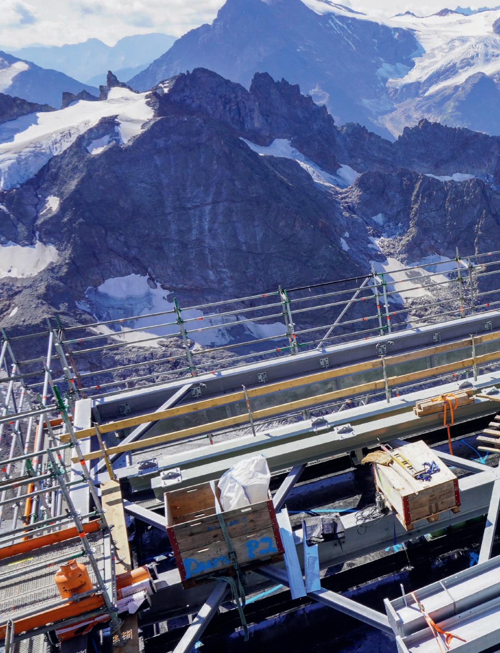
Gesichertes Baumaterial, das auch bei Windgeschwindigkeiten von 200 km/h an Ort und Stelle bleibt.
