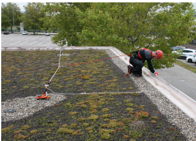
Abb. 3: Mitlaufendes Auffanggerät an beweglicher Führung als Verbindungsmittel zur Anschlageneinrichtung, manuell so eingestellt, dass ein Absturz verhindert wird
