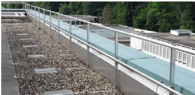
Abb. 24 Ausstattungsstufe 3: Seitenschutzsystem mit Auflast bodeneben montiert
