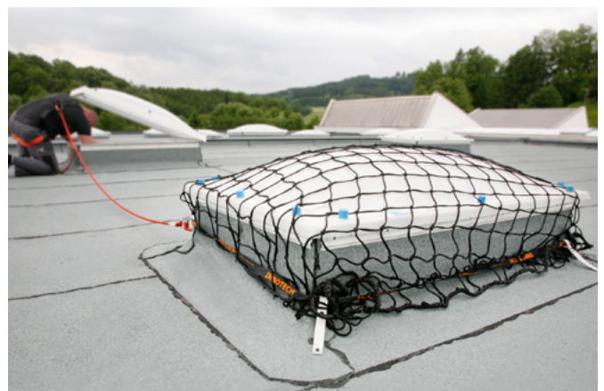
Abb. 41: Temporäre Lichtkuppelsicherung (Nur für Massaufnahme und Montage Kollektivschutz, nicht für regelmässige Instandhaltungsarbeiten)
