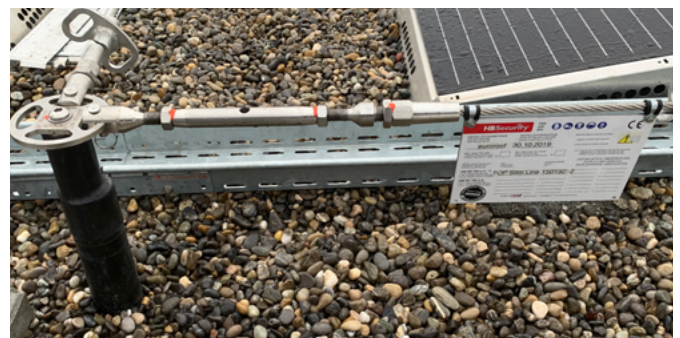
Abb. 44: Objektspezifische Kennzeichnung einer Seilanlage
