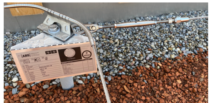
Abb. 45: Objektspezifische Kennzeichnung einer Seilanlage
