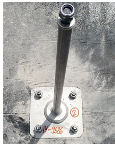
Abb. 43: Stütze fertig montiert und für die Montagedokumentation nummeriert (Objektnummer und Stützennummer, alle Befestigungen sichtbar)
