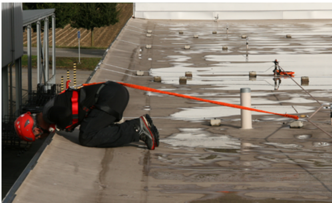
Abb. 9: Arbeiten mit Rückhaltesystem an temporärem Seilsystem
