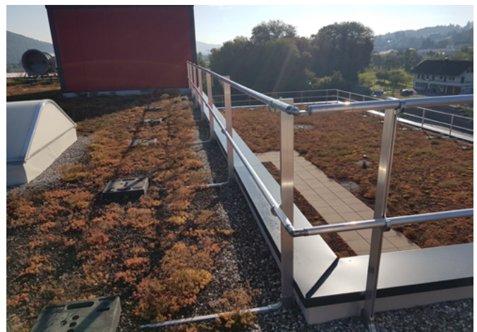
Abb. 23 Ausstattungsstufe 3: Seitenschutzsystem mit Auflast
