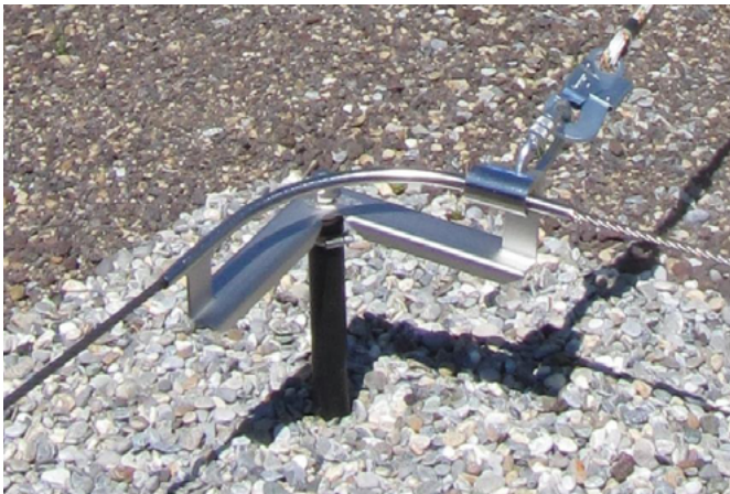
Abb. 17: Frei überfahrbarer Eckpunkt gemäss Herstellerangabe
