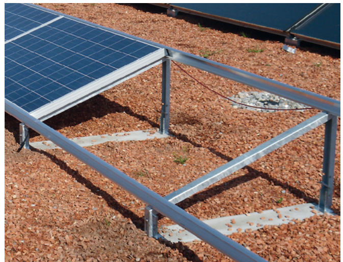
Einbau der Flachdachaufständerung auf einer Druckverteiplatte (Betonsockel)
