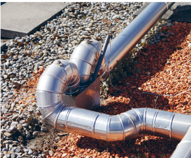
Solartherme-Anlage: Leitungsführung, Deckendurchbruch offen (links), mit Abdeckung (rechts)
