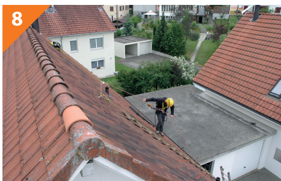
Abb: gesicherte Begehung der ganzen Dachfläche
