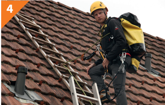
Abb: Sicherung mittels Karabiner
