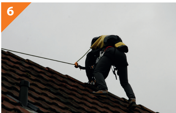
Abb: Parallel Sicherung zum First
