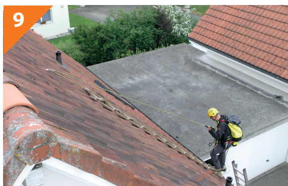
Abb: Demontage des Geländerseils
