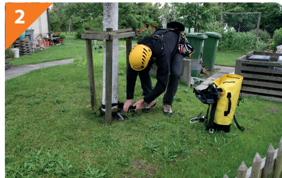
Abb: Temporärer Anschlagpunkt
