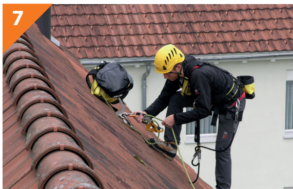
Abb: Sicherung mit Mastwurf
