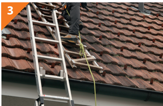
Abb: Erste Sicherung mittels Stahlkarabiner und Achterknoten an der Anschlagrichtung
