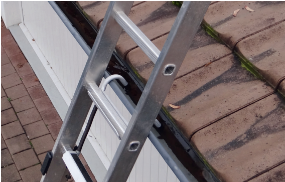
Abb: Gesicherte Anstelleiter
