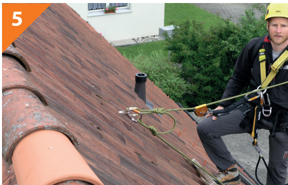
Abb: Sicherung mittels Achterknoten
