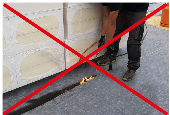
Abb. 19: Besonderes Gefahrenpotential bei Materiallager. Die Flamme kann durch die Sogwirkung unter das Material ziehen und dieses von unten her entzünden.
