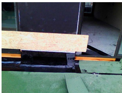
Aufnahme der Situation vor dem Schweißen dieses Anschlusses. Die Bauteiloberfläche im Fadenkreuz ist ca. 1,2 °C kalt.
