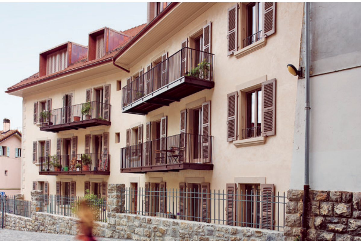
Bei diesem sanierten Gebäude in Lausanne sind die Balkone thermisch vom Gebäude getrennt und erzeugen so keine Wärmeverluste. Foto: Thomas Hensinger
