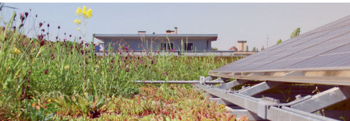
Eine Dachbegrünung bietet viele Vorteile und lässt sich problemlos mit einer Photovoltaikanlage verbinden. Foto: Stephan Brenneisen, ZHAW
