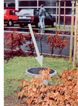
Ein gutes (links) und ein schlechtes Beispiel (rechts) für eine Aussenluftfassung. Ist die Fassung ebenerdig angebracht, können Staub, Blätter und andere Immissionen die Anlage verschmutzen.
