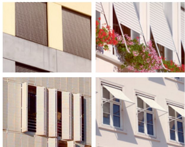
Aussen liegend, beweglich und voll deckend: Lamellenstoren, Rollläden, Fensterläden und Sonnenstoren (v. l. n. r.) schützen wirksam vor Hitze.
