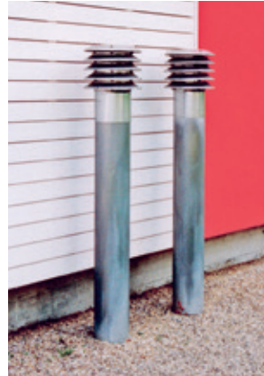
Ein gutes (links) und ein schlechtes Beispiel (rechts) für eine Aussenluftfassung. Ist die Fassung ebenerdig angebracht, können Staub, Blätter und andere Immissionen die Anlage verschmutzen.
