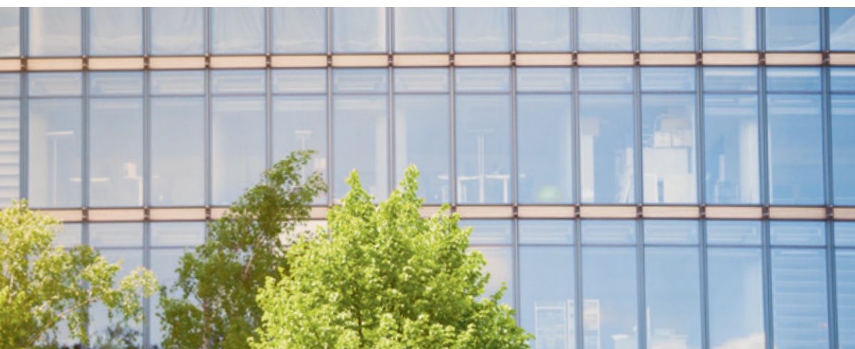
Der sommerliche Wärmeschutz beeinflusst die Behaglichkeit in Gebäuden erheblich und wird aufgrund der zunehmenden Anzahl von Hitzetagen immer wichtiger. Quelle: iStock
