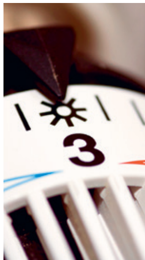
Thermostatventile regeln den Durchfluss des warmen Heizwassers durch die Heizkörper und passen die Leistung der Heizungsanlage dem Bedarf an.
