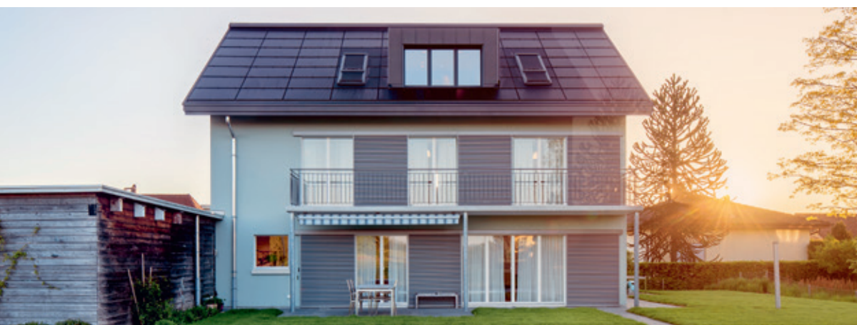
Sind bei einem Dach Sanierungsmassnahmen notwendig, lohnt es sich, die gleichzeitige Installation einer Photovoltaikanlage zu prüfen. Das gilt auch bei einem Ausbau des Dachgeschosses wie bei diesem Einfamilienhaus in Wolfwil. Quelle: Zihler Architekten + Planer AG
