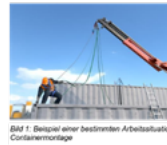
Bild 1: Beispiel einer bestimmten Arbeitssituation Containermontage
