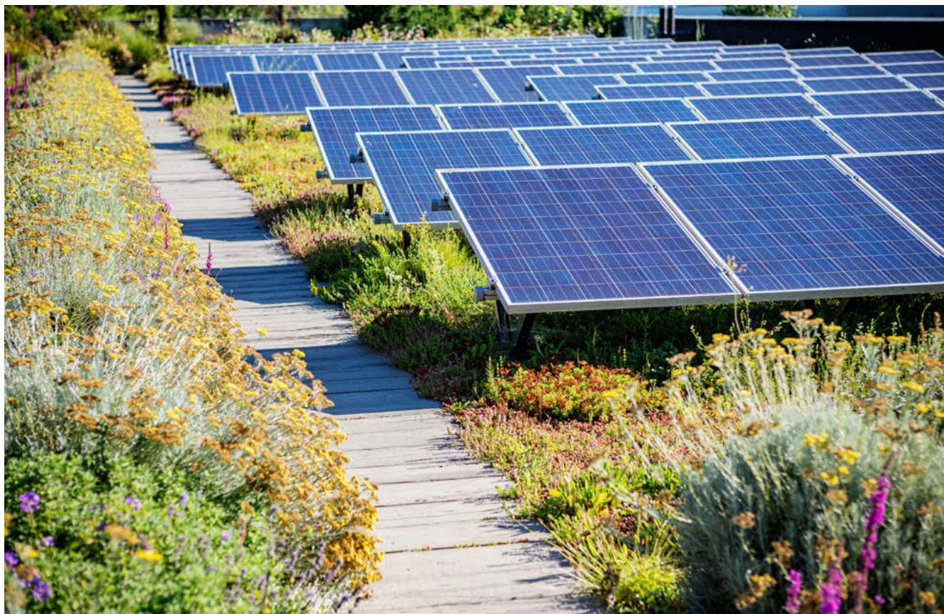
Abbildung 3: Kombination Intensiv-/Extensiv-Dachbegrünung neben PV-Anlage, Quelle: Contec
