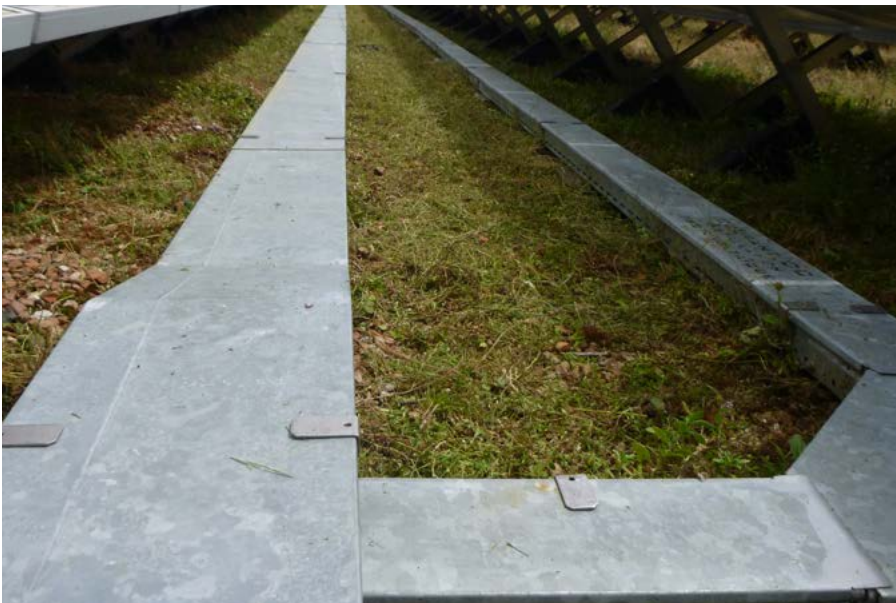
Abbildung 9: Kabelführung zwischen den PV-Modulen, Quelle: contec
