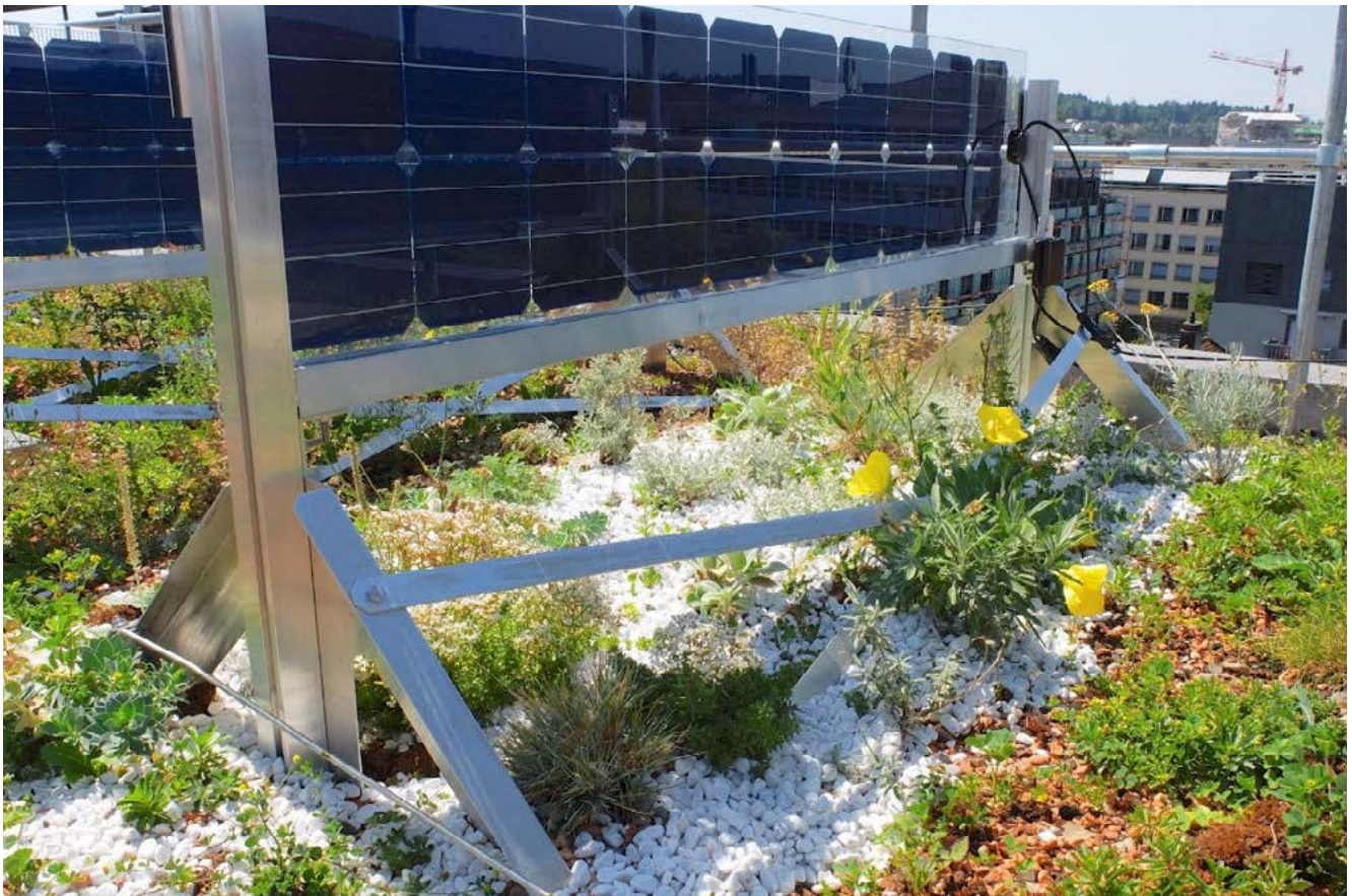
Abbildung 18: Testanlage der ZHAW, Quelle: Solarspar
