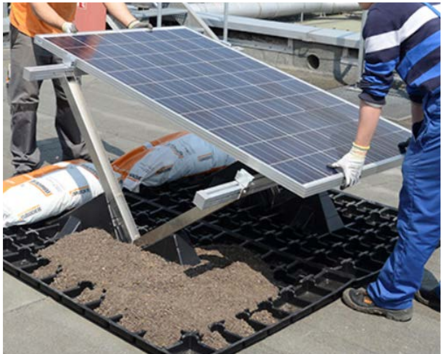
Abbildung 6: Auflastsystem für PV-Aufständerung, Quelle: Bauder
