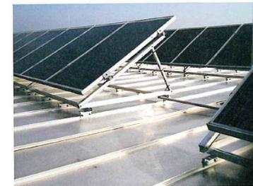
[6.2.17] Aufgeständerte Anlage auf einer Doppelstehfalzdeckung mit Falzklemmen befestigt
