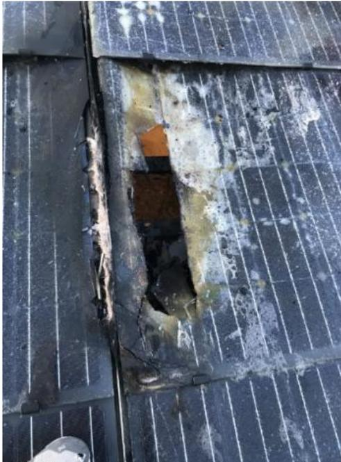
An dieser Stelle war genau die Auflage auf dem EPDM und dieser hat vermutlich die Brandlast weitergetragen. Der Brand konnte rasch gelöscht werden. "Wir denken aber, dass wir dank dem schwer brennbaren Unterdachfolie in der kurzen Zeit keine grössere Brandausbreitung hatten".
