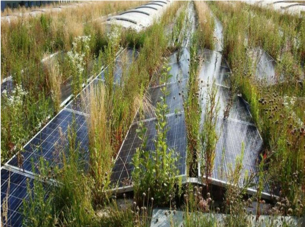
Falsche Planung/Auslegung, so dass ein ordentlicher Unterhalt nicht mehr ausgeführt werden kann. Zu tief aufgeständerte PV-Anlage bei einer Kombination von Dachbegrünungen und Solarenergieanlagen
