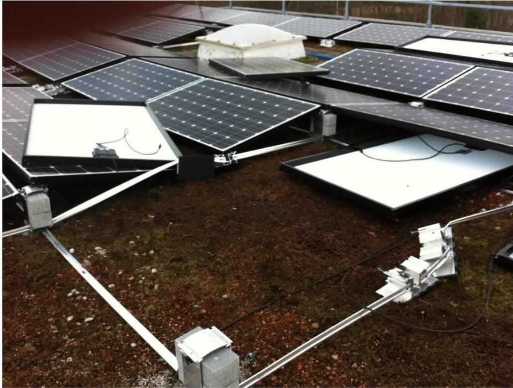
Sturmschaden, zu schwach dimensionierte Statik mit unzureichenden Befestigungen und Ballastierungen. Lebensgefährlich!
