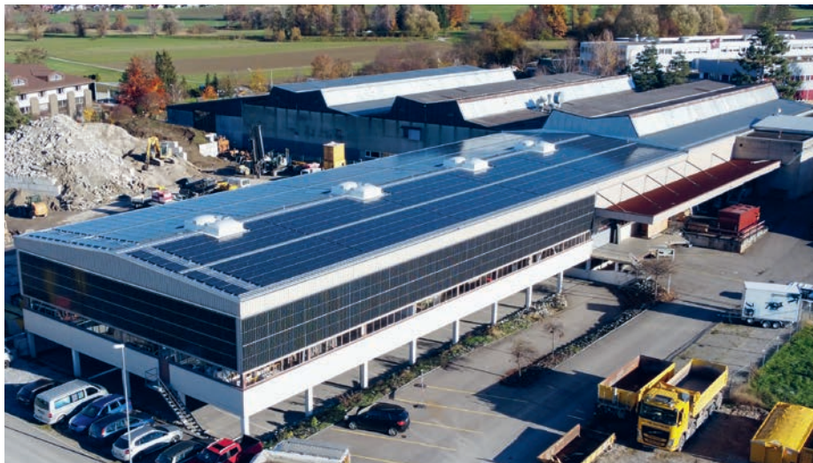
Auf den Dächern der Fabrikatur AG in Wetzikon wird das Flachdach etappenweise mit einer Photovoltaik-Anlage ergänzt.
