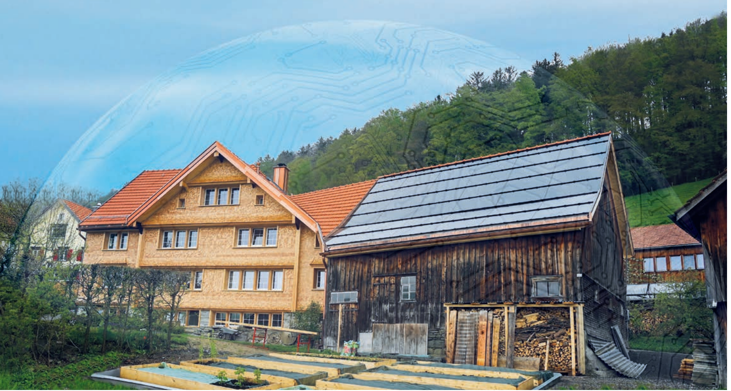
Ganzheitliche Modernisierung eines 300 Jahre alten Appenzellerhauses – renovierte Gebäudehülle und Scheune mit neuer Photovoltaik-Anlage.
