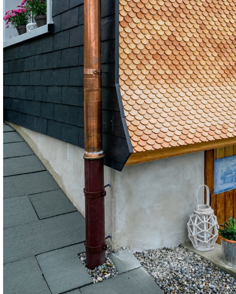
Ein schön gelöstes Detail beim Zusammenschluss Fassadenecke der Schieferfassade zum Rundschindelschirm
