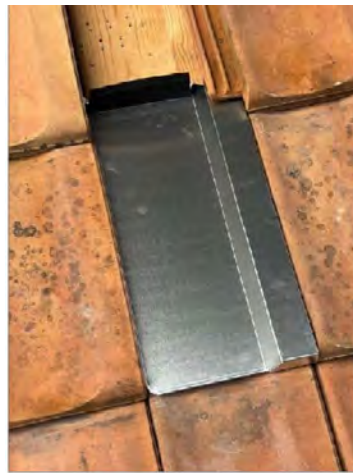
Fig. 4 Incollare il nastro sigillante sulla tegola metallica, montare e fissare la tegola metallica, fissare il gancio di montaggio
