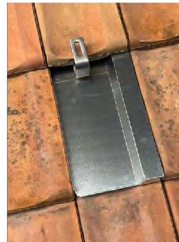
Fig. 4 Incollare il nastro sigillante sulla tegola metallica, montare e fissare la tegola metallica, fissare il gancio di montaggio
