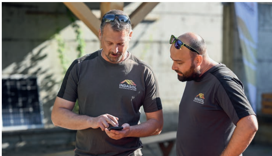
Michel Christen (links) und Marco Schüpfer prüfen die Leistung der neuen Photovoltaik-Anlage.
