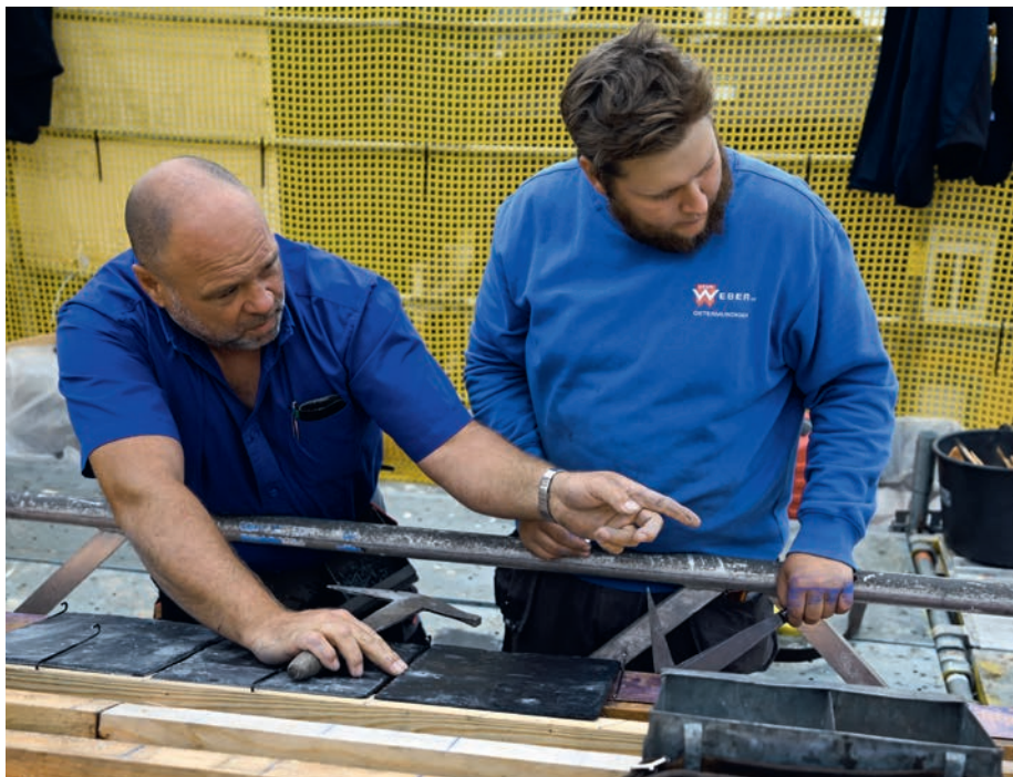
Seite an Seite mit den Lernenden: Bei der Arbeit auf der Baustelle vermittelt Markus Weber das «Gspüri» für das richtige Arbeiten.
