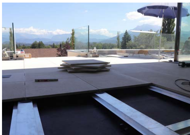
Fig. 7: Pose des dalles en céramique / grès cérame sur un système de rails.
