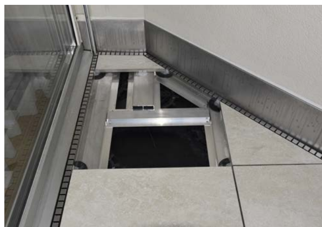
Fig. 20: les systèmes de rails servent à poser au mieux les revêtements en dalles de manière optimale et permettent de le faire de façon professionnelle, notamment lorsque les raccords sont orthogonaux et difficiles.
