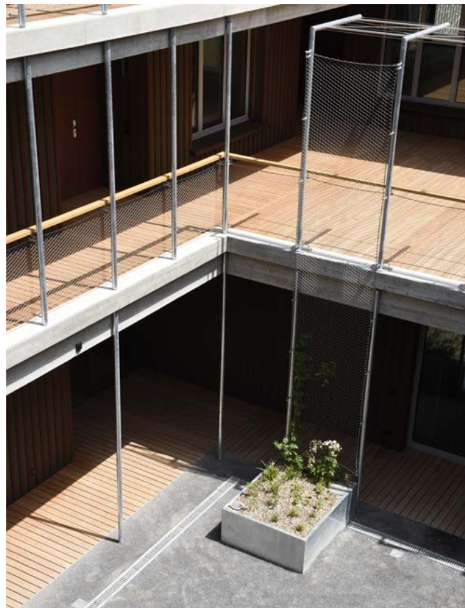
Fig. 10: terrasses et coursives avec caillebotis en bois.
