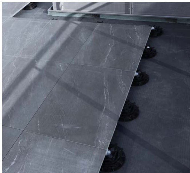
Fig. 26: terrasse avec dalles en céramique / grès cérame posées sur plots.
