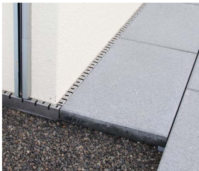
Fig. 33: raccord de bord avec profilé de joint.
