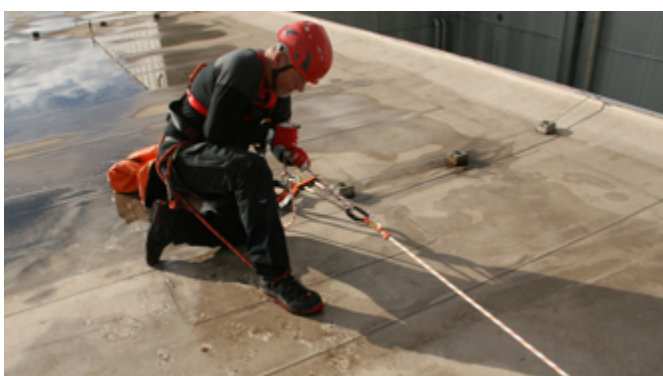
Fig. 10: Système temporaire à corde (ligne de vie) avec mousqueton fixé au PAI
