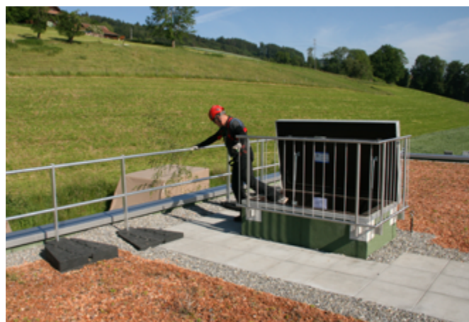
Fig. 36: Fenêtre d'accès au toit sécurisée par une protection latérale hors la zone de danger avec risque de chutes élevé. Avec une planification optimale, la fenêtre d'accès au toit conduirait au centre de la zone de danger
