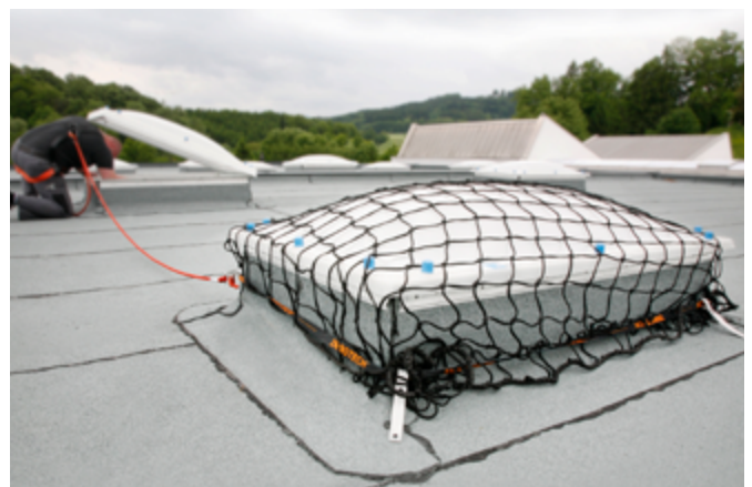
Fig. 39: Sécurisation temporaire d'une coupole de toit
