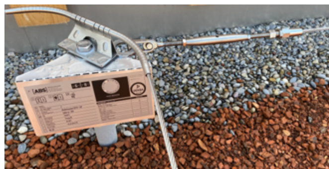
Fig. 43: Marquage spécifique à l'objet d'une installation de cordes
