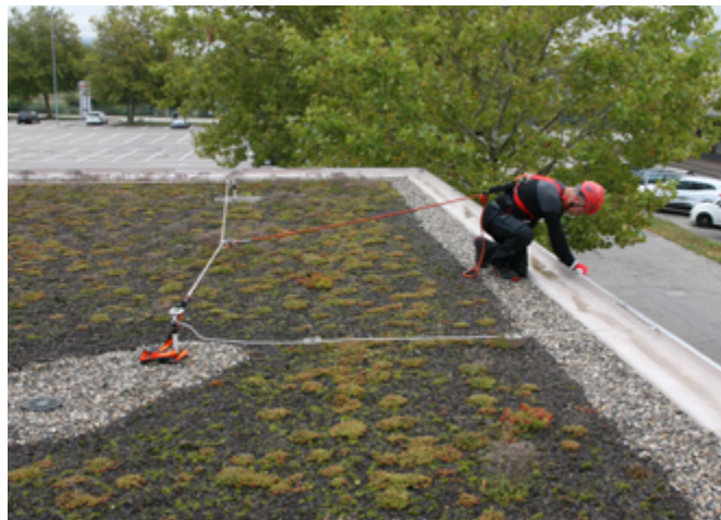
Fig. 3: Appareil d’amortissement des chutes avec guidage mobile comme moyen de raccordement au dispositif d’ancrage, réglage manuel, qui empêche une chute
