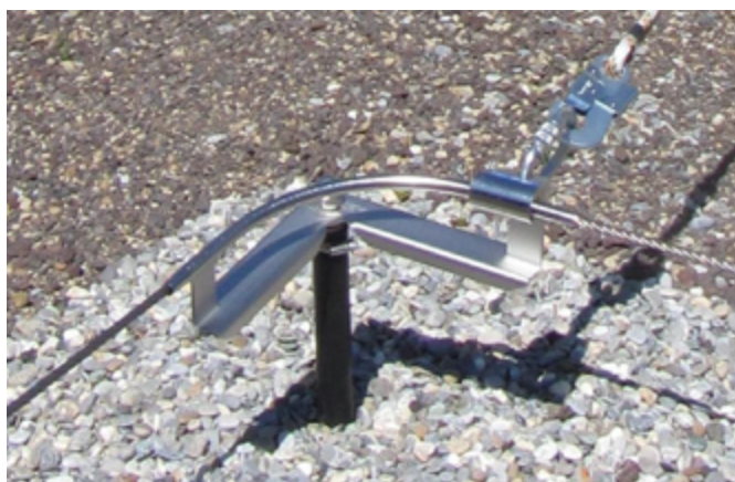
Fig. 17: Passage d'angle librement surpassable selon les indications du fabricant
