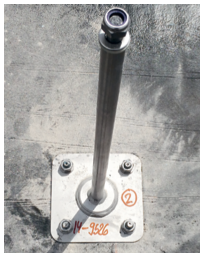
Fig. 41: Support monté et numéroté pour la documentation de montage (numéro d'objet et numéro de support)
