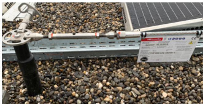
Fig. 42: Marquage spécifique à l'objet d'une installation de cordes
